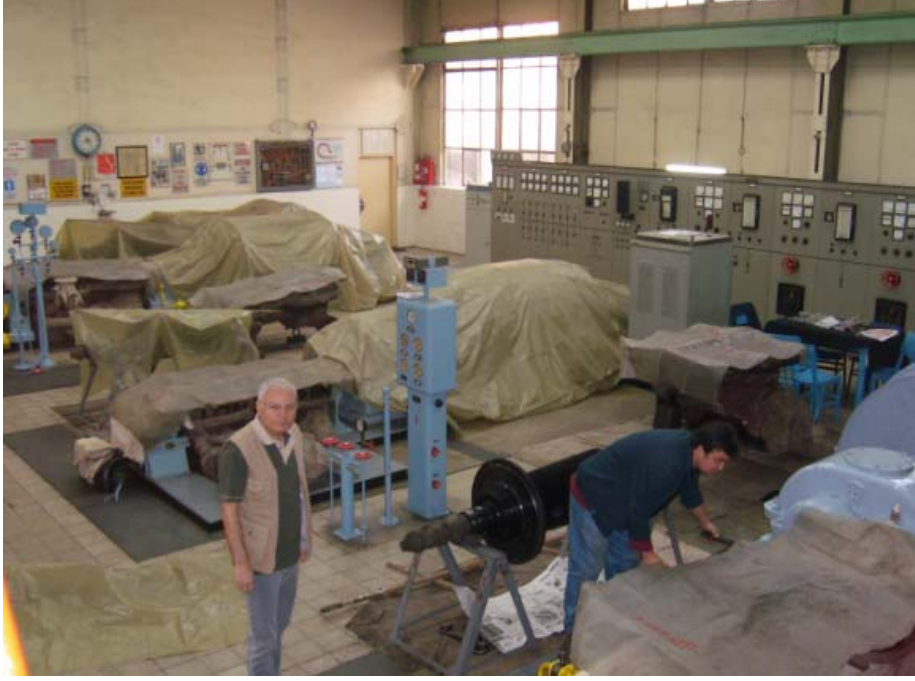
Şekil 3.3 Alpullu şeker fabrikası türbin dairesi
