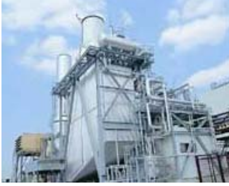
Şekil 2.6 Atık ısı kazanı (Anonim,2008)
