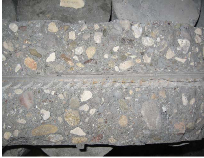
Şekil 3.7. Donatı sıyrıldıktan sonra numune kesit görünümü
