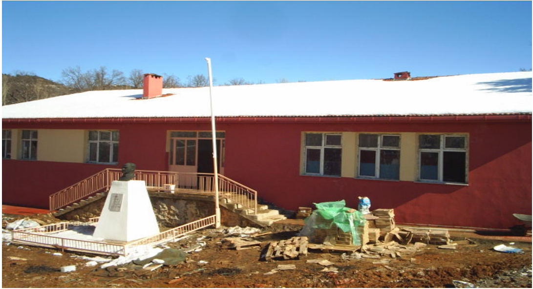
Şekil 4.9. Güçlendirme uygulaması tamamlanan yığma yapı (Isparta Kesme İ. O.)
