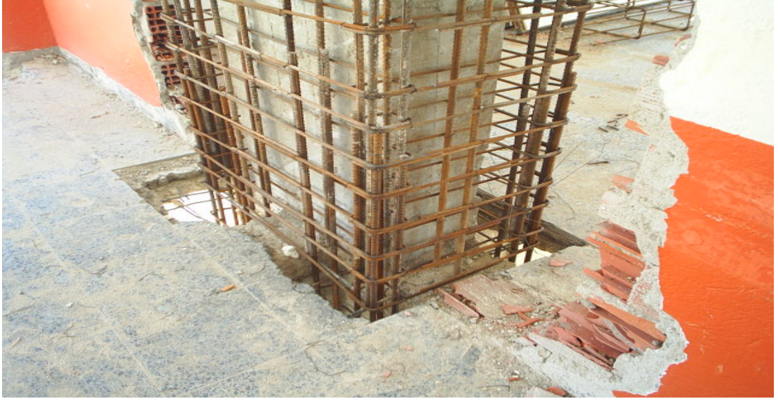
Şekil 1.2. Kolon güçlendirmesi (Yalvaç Kumdanlı İ. O.)
