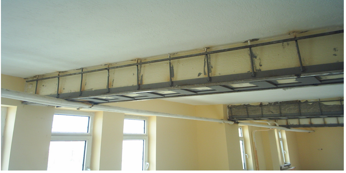
Şekil 1.3. Kiriş güçlendirmesi (Isparta Selahattin Seçkin ve Öğretmenler İ. O.)
