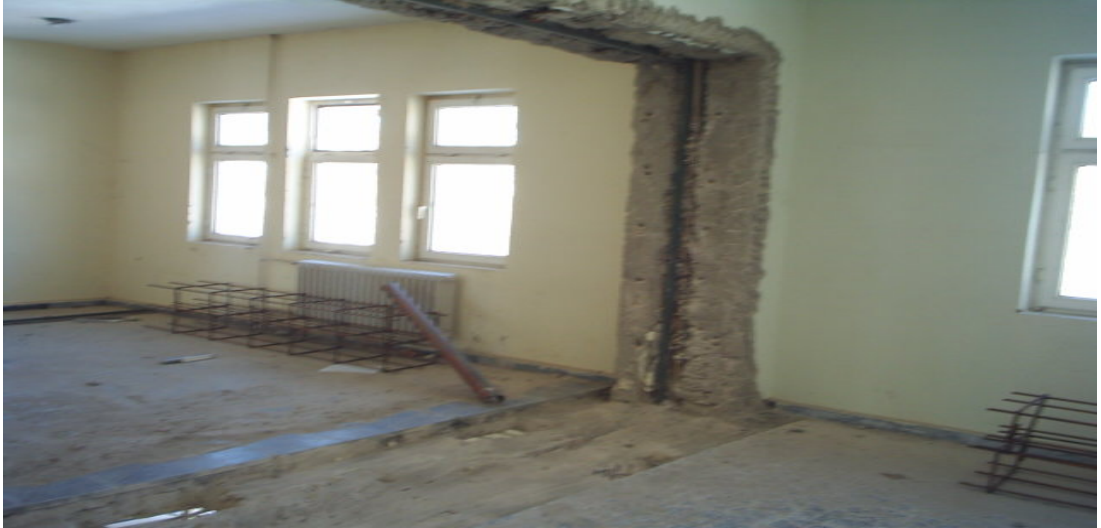
Şekil 1.4. Döşeme güçlendirmesi (Isparta Selahattin Seçkin ve Öğretmenler İ. O.)
