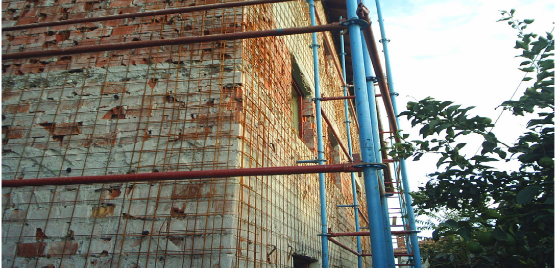
Şekil 1.7. Hasır donatı uygulaması (Demre Yusuf Özek İ. O.)
