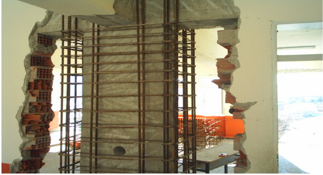
Şekil 4.6. Karot numunesi alınan yapı elemanı (Sütçüler Kesme P. İ. O.)
