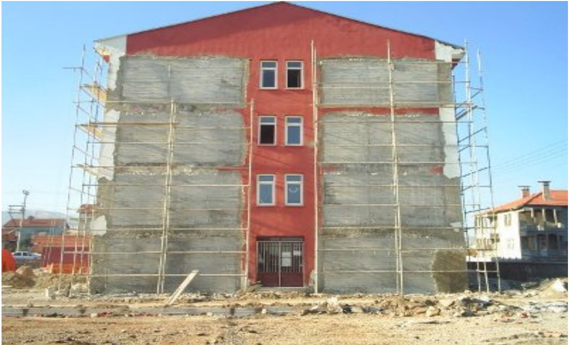
Şekil 1.11. Perde güçlendirmesi (Isparta Selahattin Seçkin ve Öğretmenler İ. O.)
