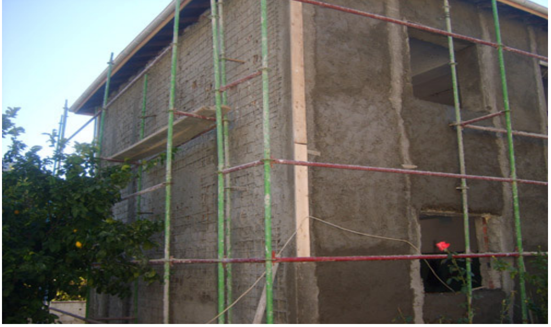
Şekil 4.8. Püskürtme beton üzerine sıva uygulaması (Turunçova Çavdır İ. O. )
