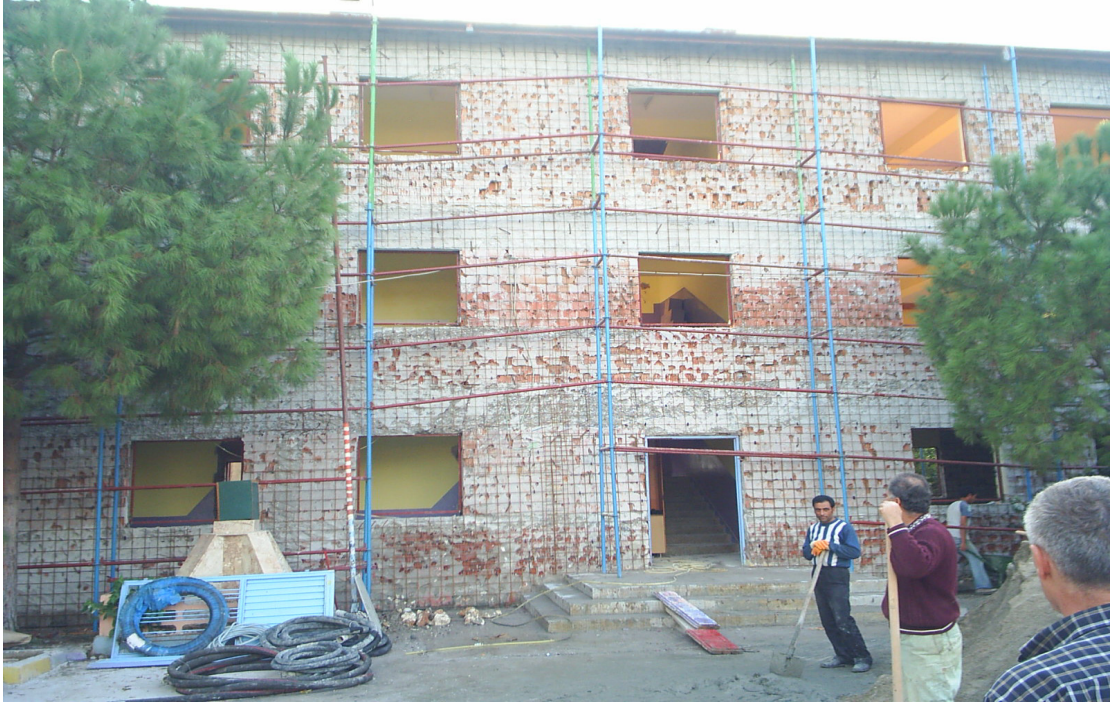
Şekil 4.7. Çelik hasır uygulaması (Demre Yusuf Özek İ. O. )
