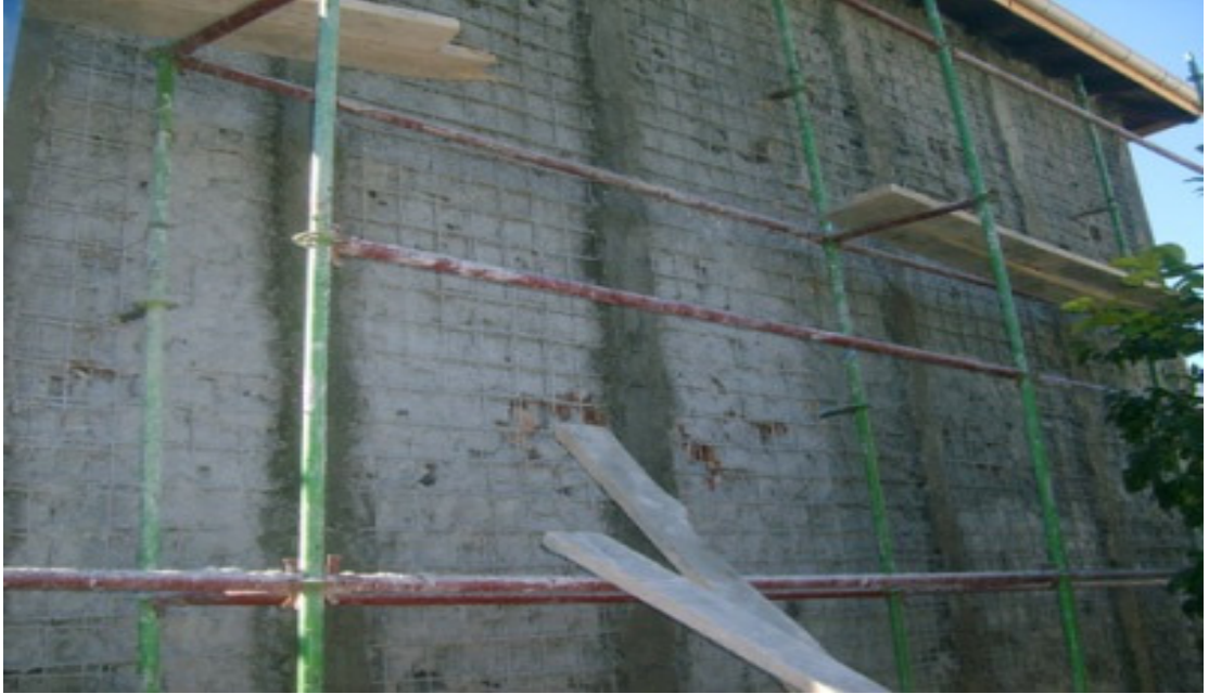
Şekil 1.8. Püskürtme beton uygulaması (Turunçova Çavdır İ. O.)
