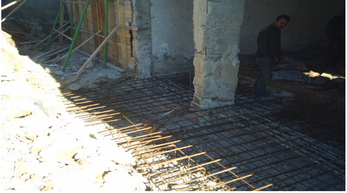
Şekil 1.6. Temel güçlendirmesi (Isparta Kesme P. İ. O)
