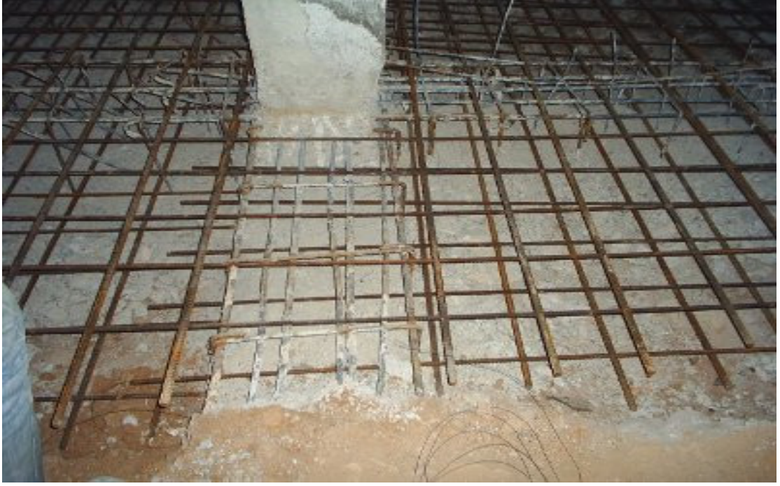
Şekil 1.10. Temel güçlendirmesi (Isparta Kesme P. İ. O)
