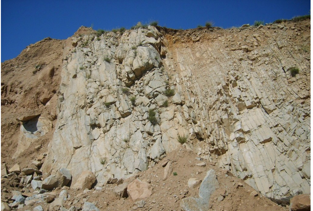
Şekil 4.11. Tefrifonolitlerde ani soğuma sonucu gelişen soğuma çatlakları (yer: Direkli köyü kuzeyi)
