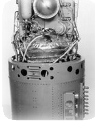
Şekil 2.3. Gemini uzay aracında kullanılan proton değişim zarlı yakıt pili
