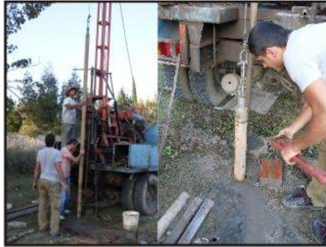
Şekil 3. 4. Kuyuya muhafaza borusu indirilmesi ve muhafaza borusu ile ilerleme
