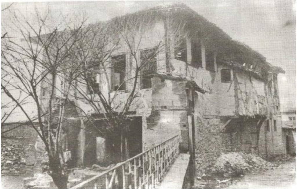
Fotoğraf 4.2. Emir Sultan Tekkesi Hareminin Yıkılmadan Önceki Harabe Hali (Taşkın, 64)
