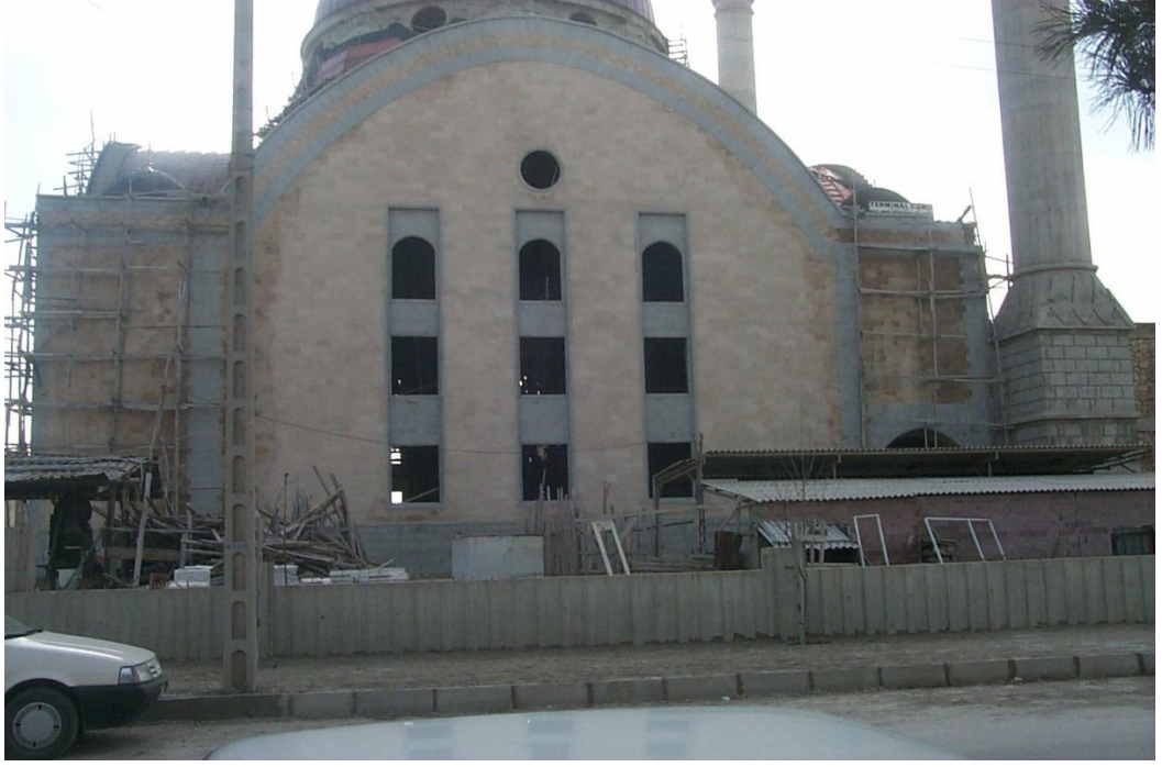
Şekil 4.2. Cami inşaatında kullanılan kaynaklanmış tüf ve andezitler, sarı renkli kısımlar kaynaklanmış tüf, açık yeşil bölgeler traki-andezitle kaplanmıştır
