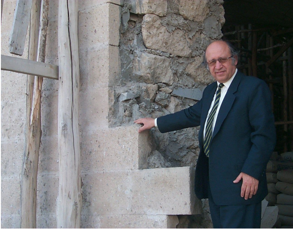
Şekil E-3: Köyke ile kaplama yapılması
