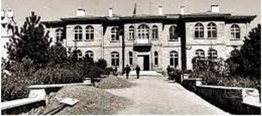
Şekil 1.2. Dönemin Nevşehir Hükümet Konağı 54
