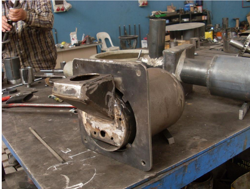
Şekil 4.4. İç cidar borusu ve yakıt yöneltme dirseği montajı
