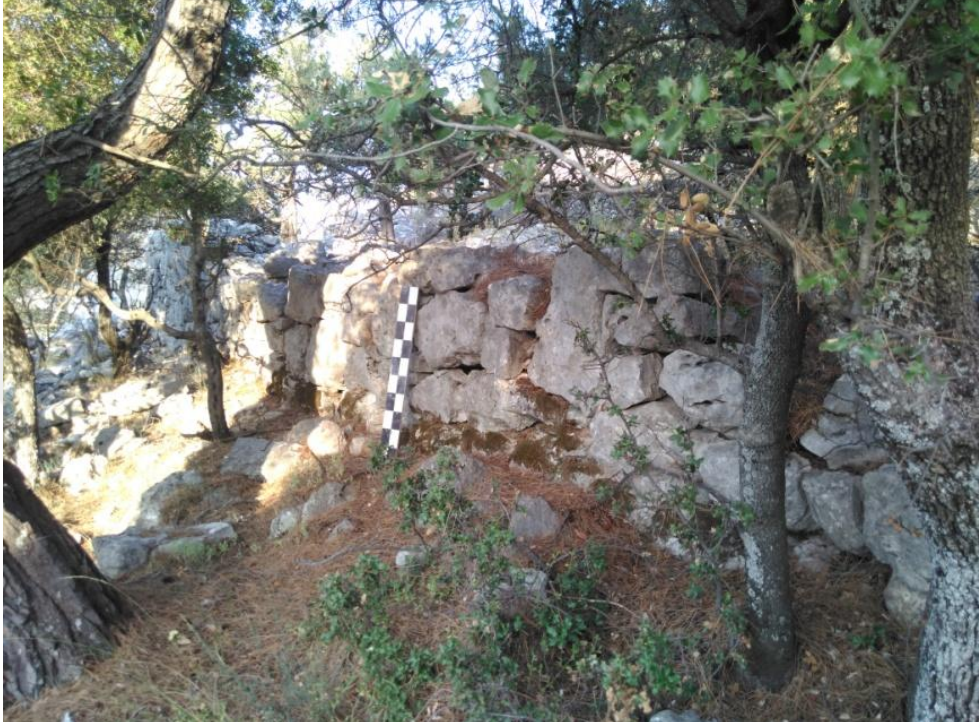
Resim 4.17: Alasın, Gücümen Tepe, sur duvarından kesit.
