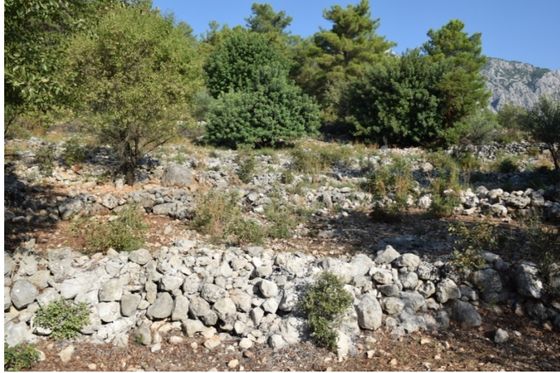
Res. 21) Tahtalı Dağı mevkinde tespit edilen paralel tipte antik teras yapıları
