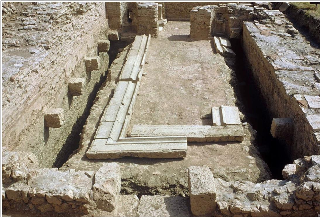
Res. 27.Magnesia Latrinası 126
