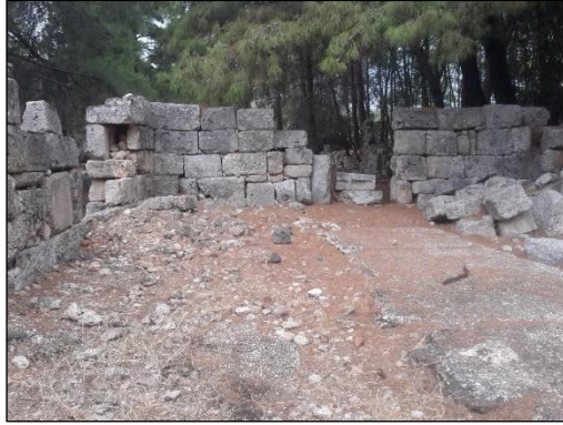
Res. 197. Latrina Kuzey Yönü Mevcut Durumu.
