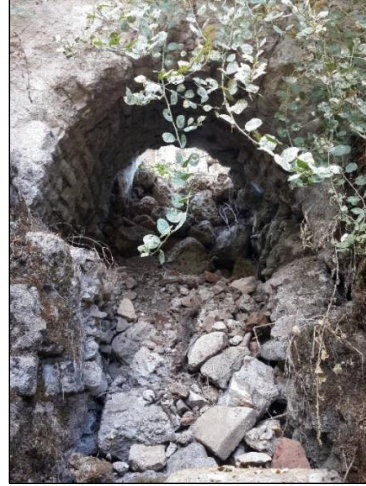
Res. 140.Caldarium Hypocaust Sistemi ve Külhan Bağlantısı.
