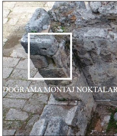
Res. 111. Doğrama Montaj Noktaları.
