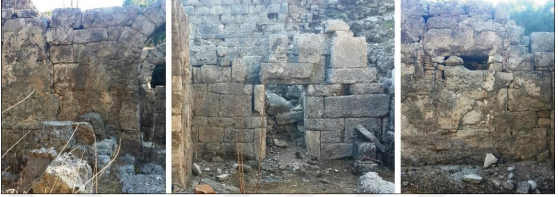
Res. 149. Frigidarium Tamiratları.
