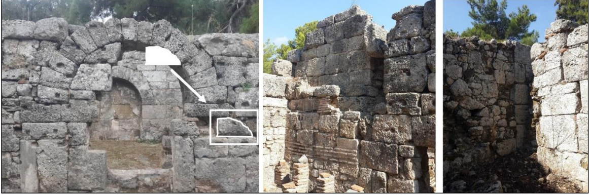
Res. 152. Tepidarium ve Laconium Duvar Tamiratları.
