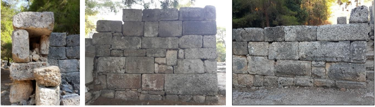
Res. 167. Latrina Duvar İmalatları.
