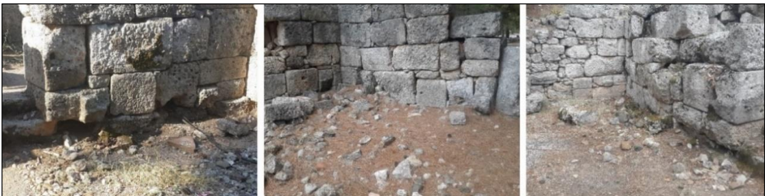
Res. 168. Latrina Oturma Plakalarının Montaj Konsolları.
