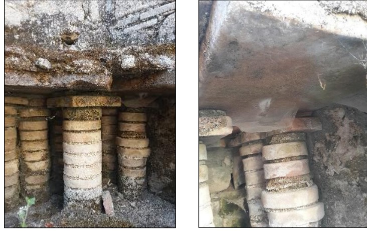
Res. 133. Laconium Hypocaust Sistemi
