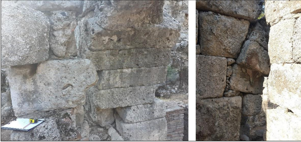
Res. 138. Caldarium Kuzey Duvarı Takviye Duvarları.
