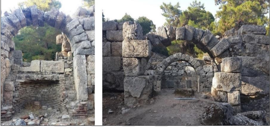
Res. 139.Caldarium Nişi.
