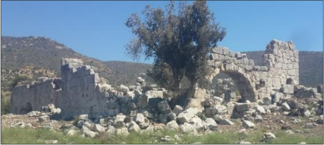
Res. 49.Merkez Hamamı Kuzeybatı Görünüşü
