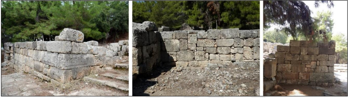
Res. 174. Latrina Taş Duvar İmalatları.
