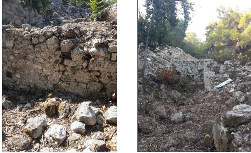
Res. 143. Praefurnium Su Tahliyesi ve Külhan Depolama Alanı.
