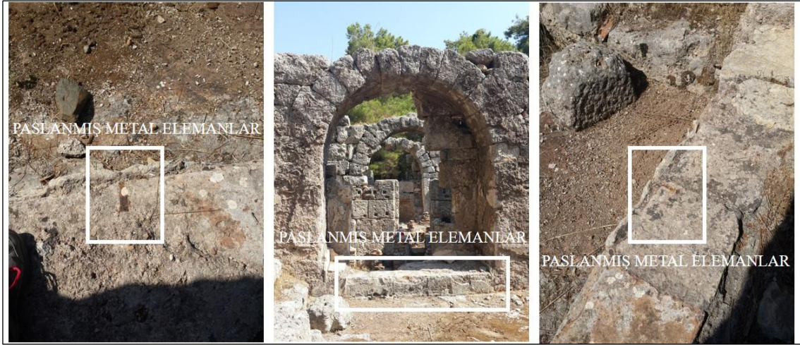
Res. 115. Frigidarium-Tepidarium Geçişindeki Kapı Montaj Elemanları
