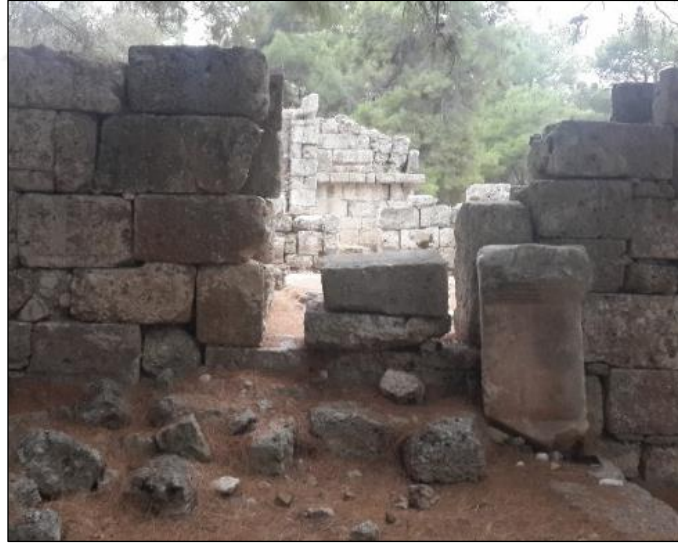
Res. 155. Latrina Kuzey ve Güney Giriş Basamakları.
