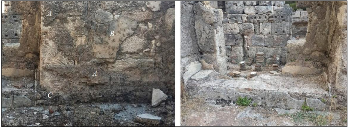
Res. 119.Duvar ve Döşeme İmalatları
