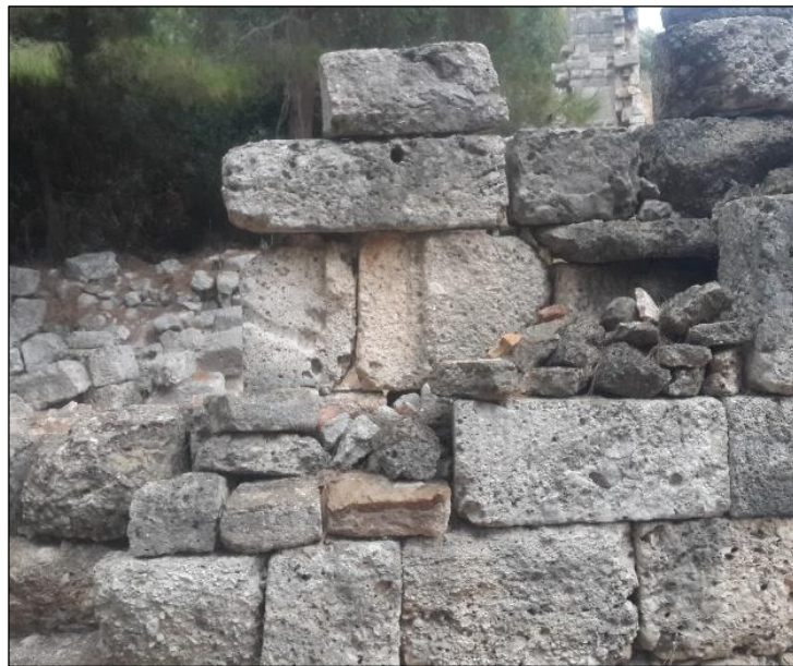
Res. 173. Latrina Duvar İmalatları.
