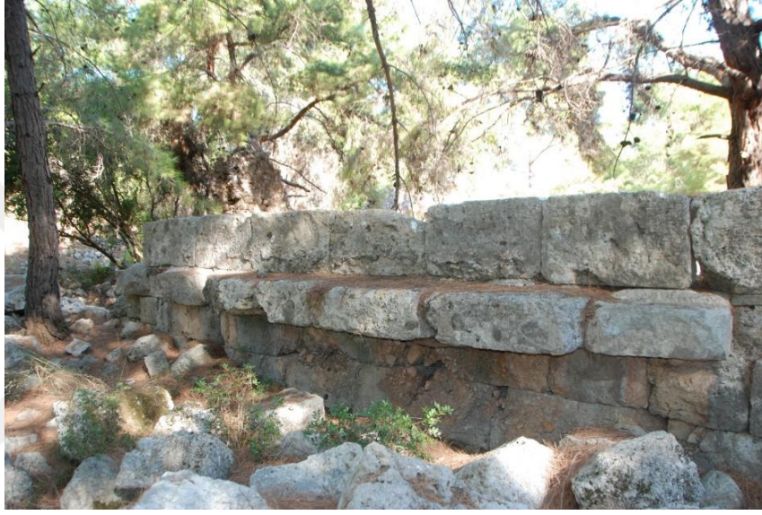
Fig. 33. Agora Güney Duvarı Pervaz Ayrıntısı
