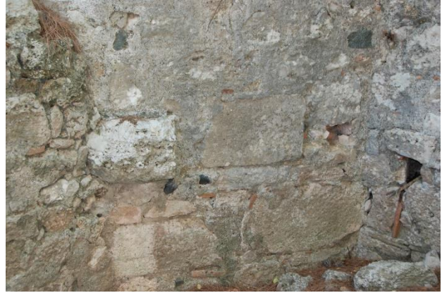
Fig. 36. Bazilika Apsisi Devşirme Malzeme Ayrıntısı
