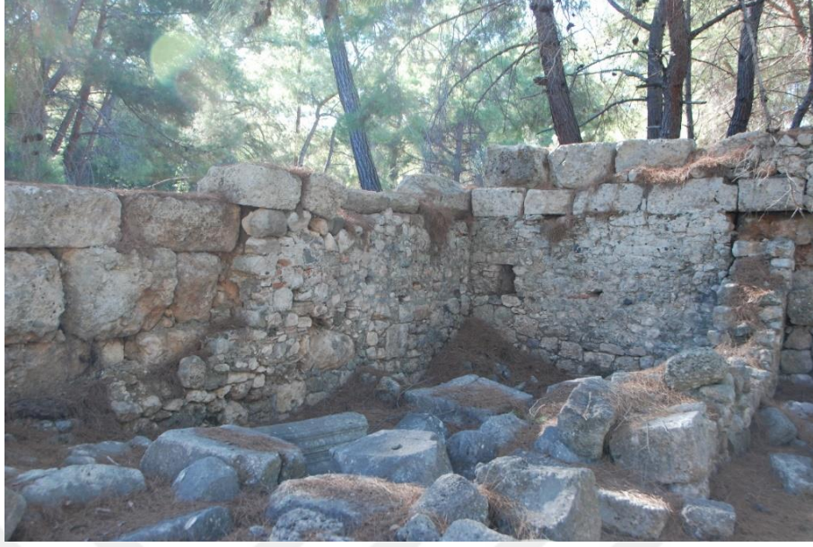
Fig. 37. Doğu Dükkanı Tamirat ve Moloz Duvar Eklentisi
