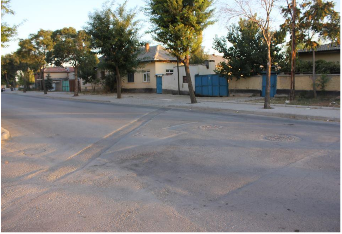
Şekil 4.20. Deneme güzergahındaki yama bozulmaları
