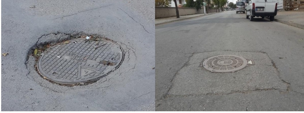
Şekil 4.18. Deneme güzergahındaki rügar kapakları
