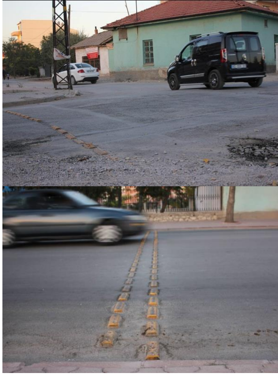
Şekil 4.19. Deneme güzergahındaki hız kesici bariyerler
