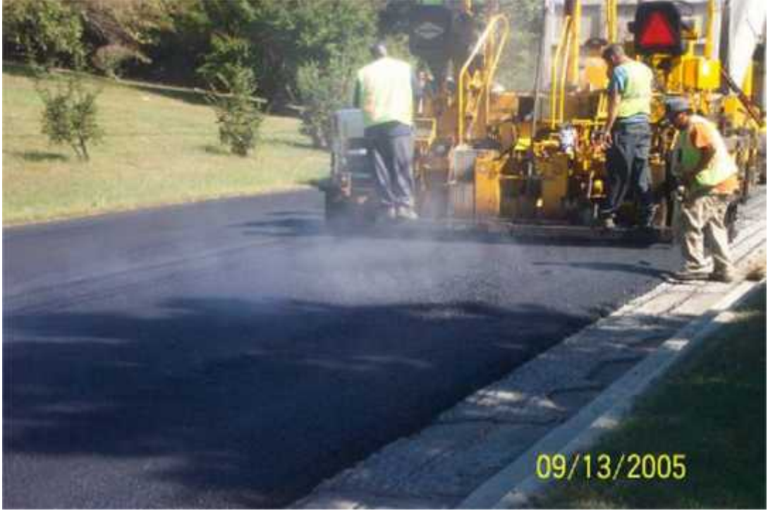
ekil 3.9. Sasobit balmumu olmadan 35% RAP' lı karı ım serilmesi (Burke, 2005)
