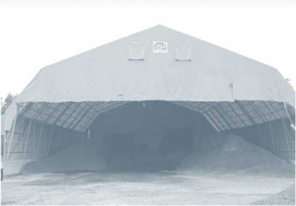
ekil 4.12. Kolo Veidekke’ in RAP depolama için kullandığı tahılabilir branda
