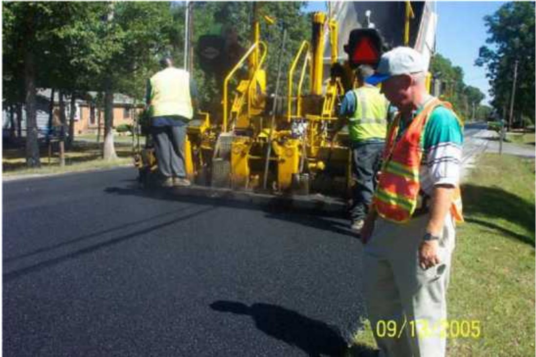
ekil 3.8. Sasobit balmumu ve 35% RAP' lı karı ım serilmesi (Burke, 2005)
