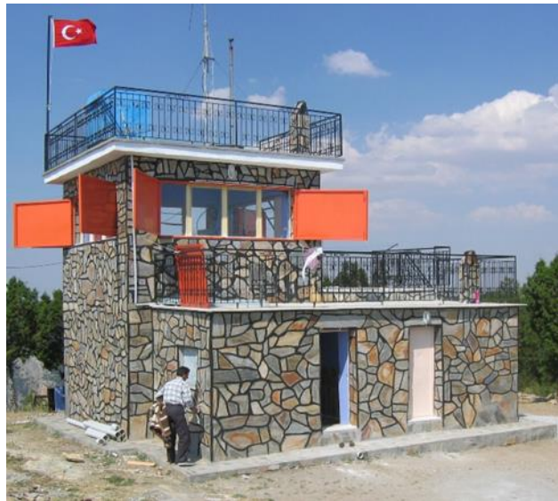
Şekil 4.9.Kule ve yangın içi haberleşme
