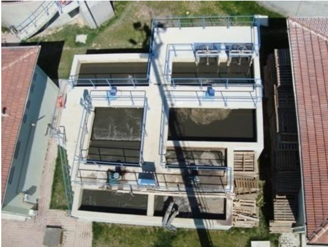
Şekil 3.9. KOS AAT hızlı ve yavaş karıştırma havuzu
