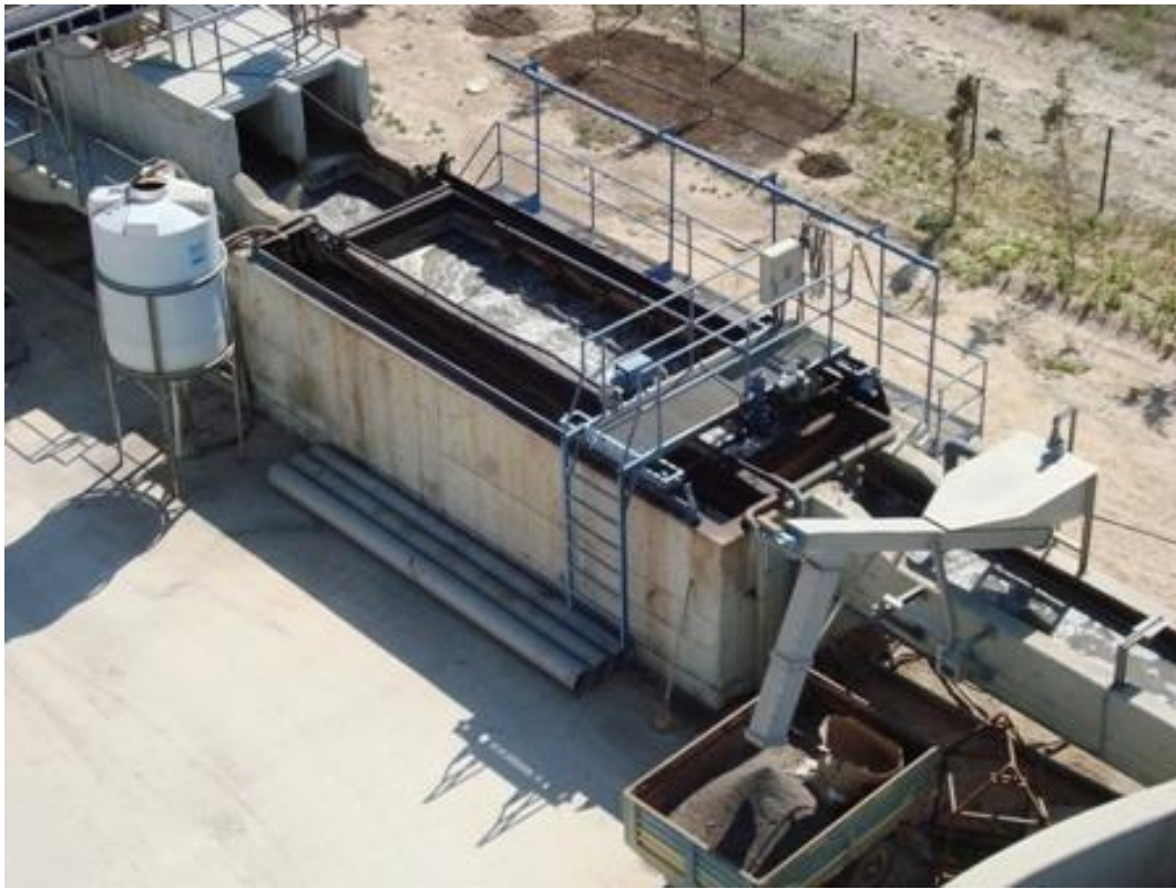
Şekil 3.6. KOS AAT havalandırmalı kum ve yağ tutucu
