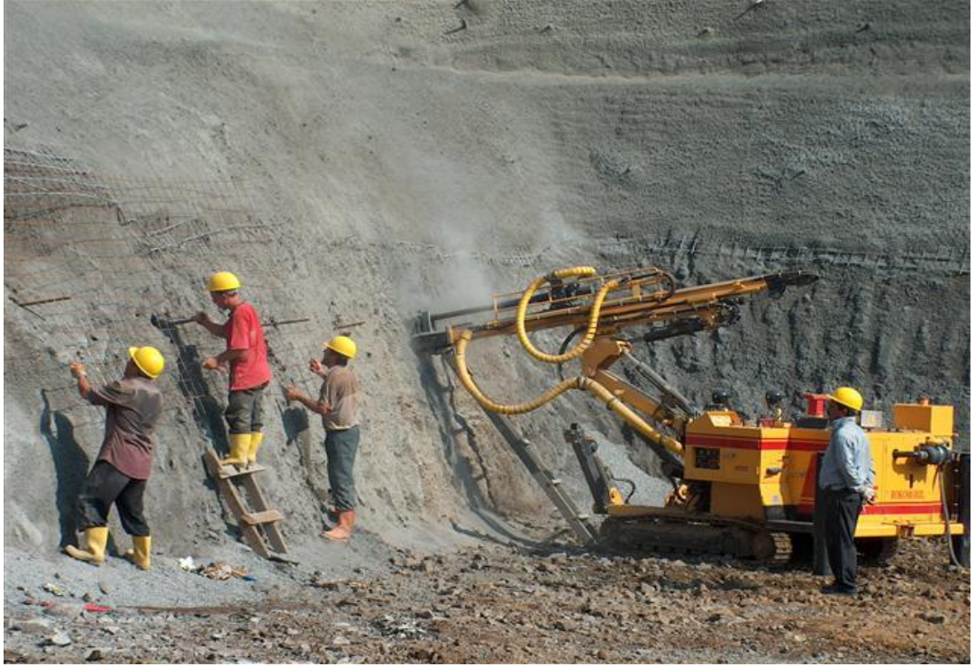
Resim 4.6. Zemin çivisi delgilerinin yapılması [64].
