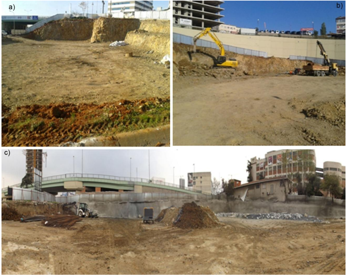
Resim 4.5. Sıyırma kazılarında genel görünüm (a ve b: Pendik İstasyonu, c: Yakacık İstasyonu)
