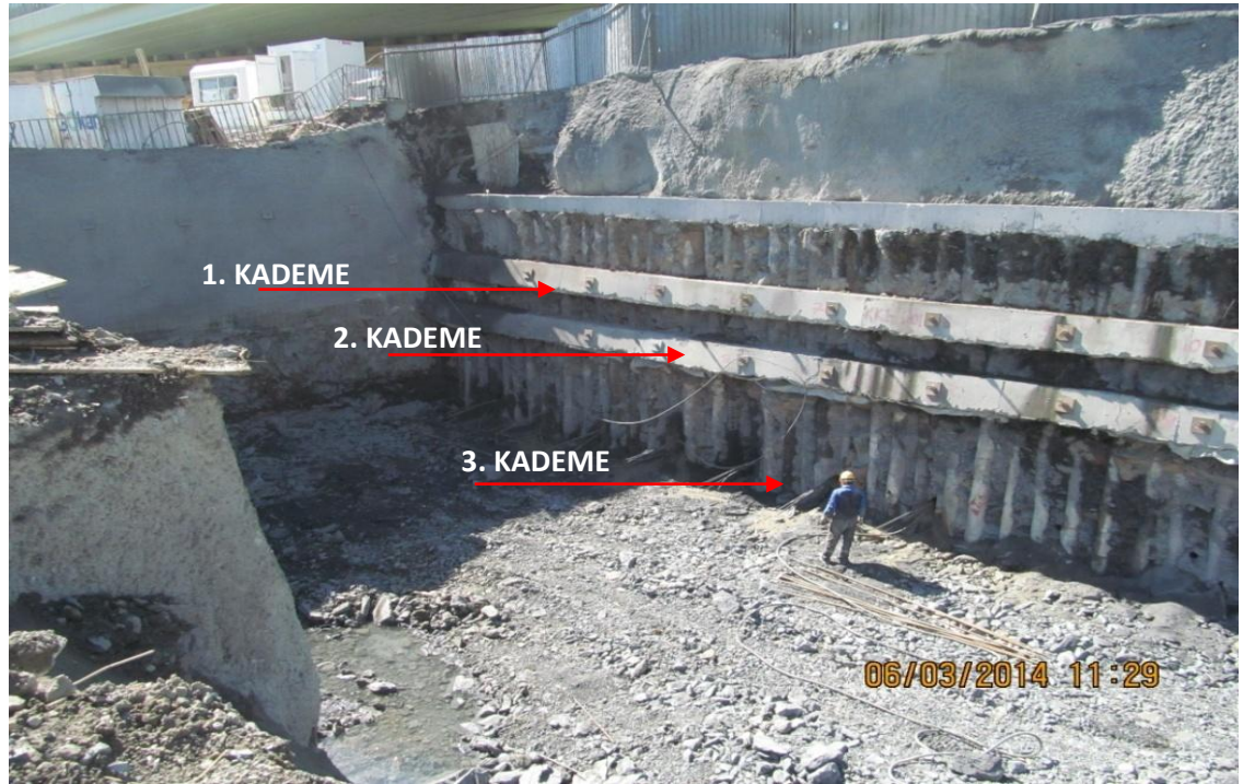
Resim 4.12. Üçüncü kademe ankraj enjeksiyonu yapılmış bir kesit (Yakacık İstasyonu doğu blok)
