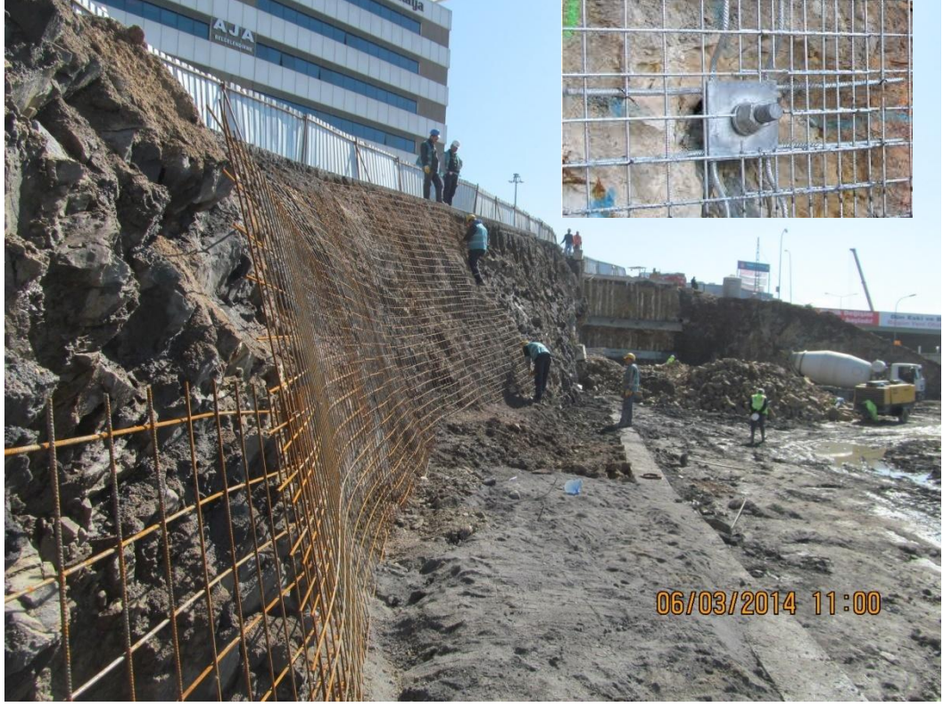
Resim 4.8. Pendik istasyonu batı blok çelik hasır döşemesi aşamasından görünüm
