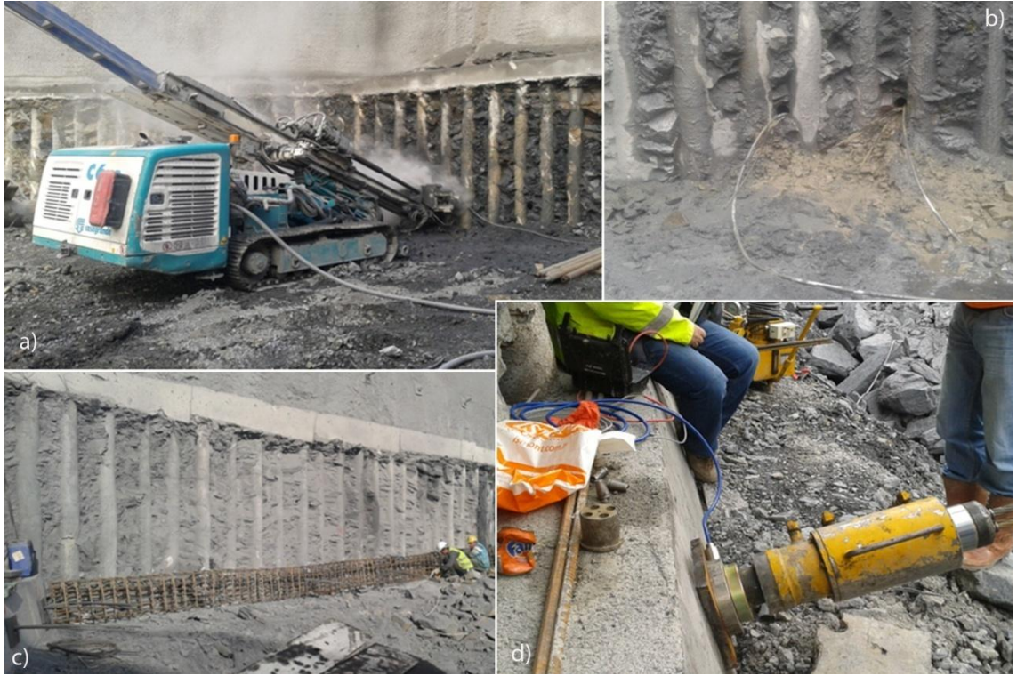
Resim 4.13. Ankraj iksa sisteminin uygulama aşamalarından genel görünüm (a: delgi işlemi, b: ankraj halatlarının yerleştirilmesi, c: göğüsleme kirişinin oluşturulması, d: çekme testleri ve kilitlenmesi)
