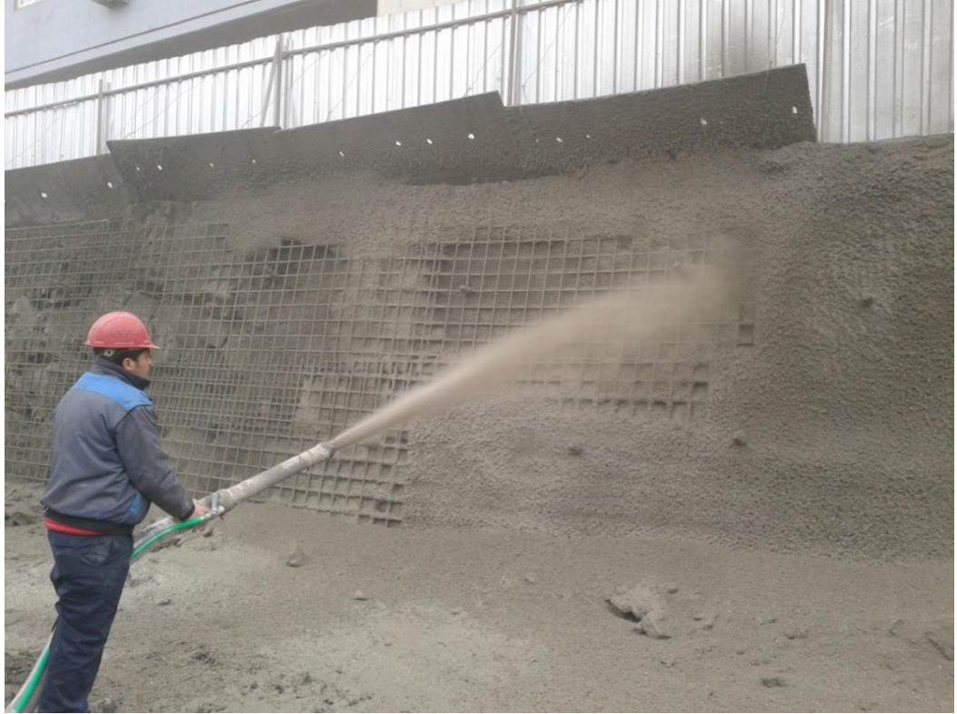
Resim 4.9. Yakacık istasyonu batı blok püskürtme beton işlemi aşamasından bir görünüm
