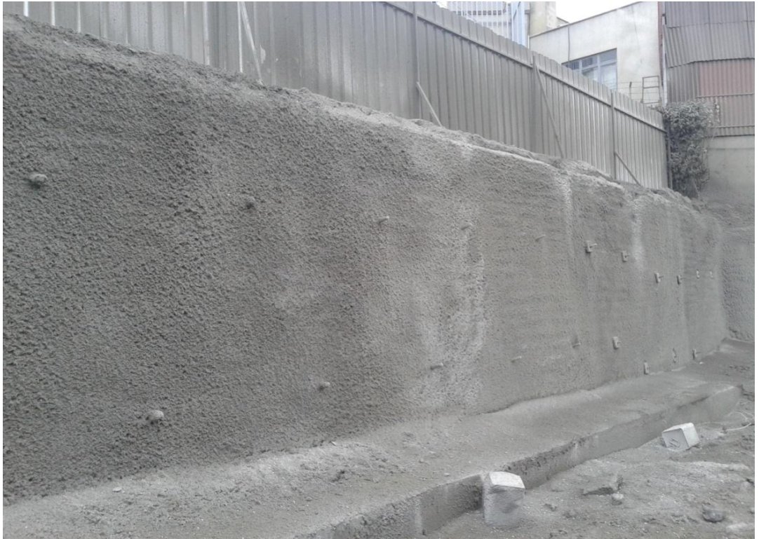
Resim 4.7. Yakacık batı blok zemin çivisi ve püskürtme beton işlemi yapılmış hali
