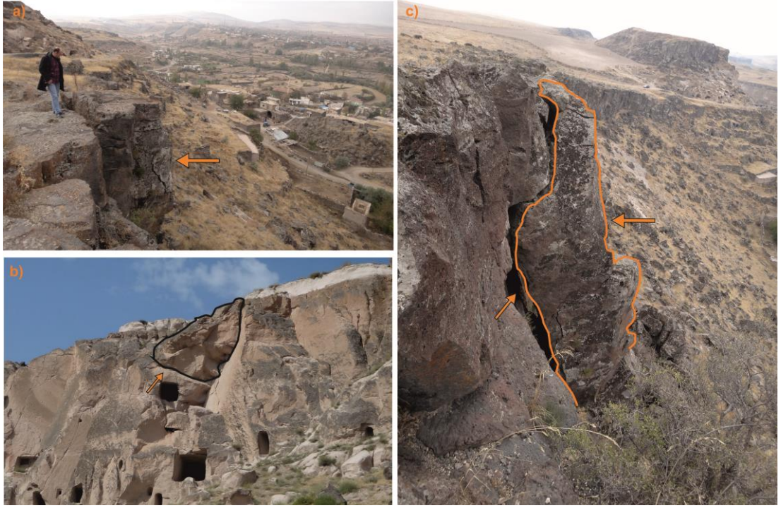
Resim 4.7 Çalışma alanında tespit edilen duraysız blokların genel görünümü
