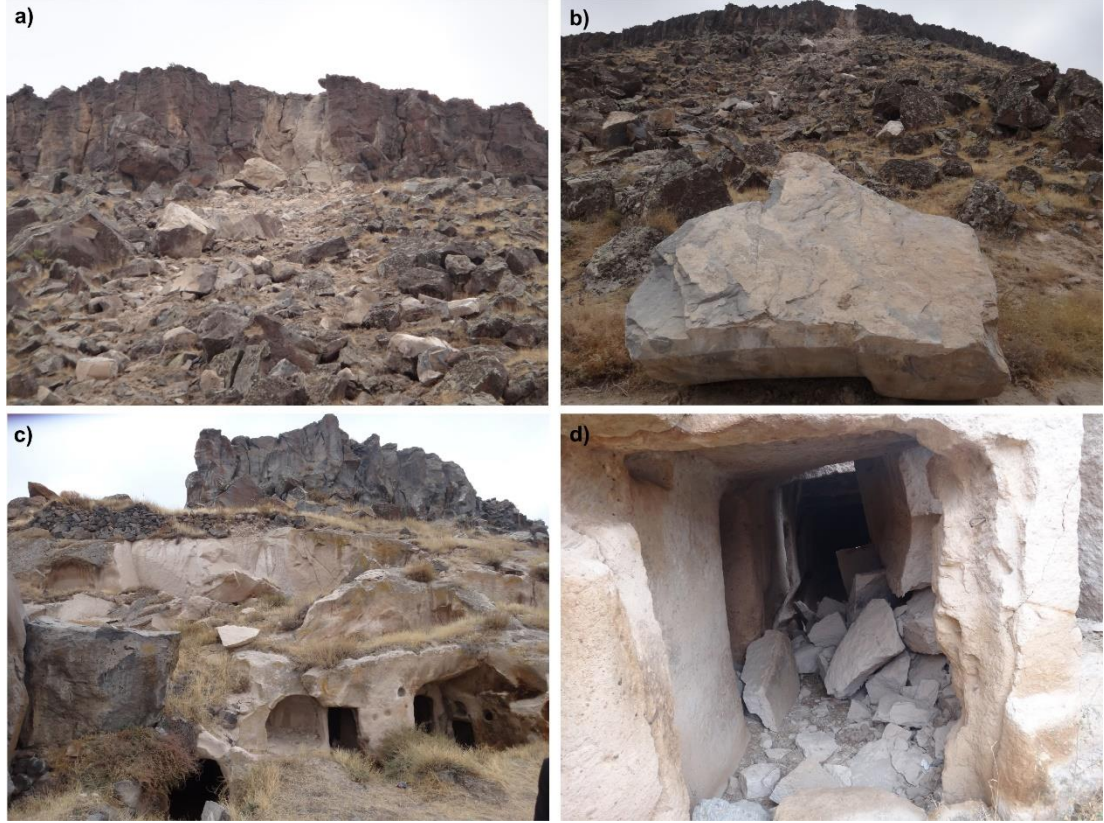
Resim 4.1 Meydana gelen kaya düşmeleri (a, b). Ekim 2011'de meydana gelen kaya düşmesi olayı (c) ve kaya düşmelerinin yeraltı şehri yapılarına verdiği zarar (d)
