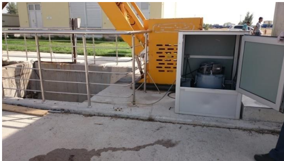
Şekil 3.10. Konya Kentsel Atıksu Arıtma Tesis giriş (a) ve çıkışından (b) atıksu örneklerinin alınması
