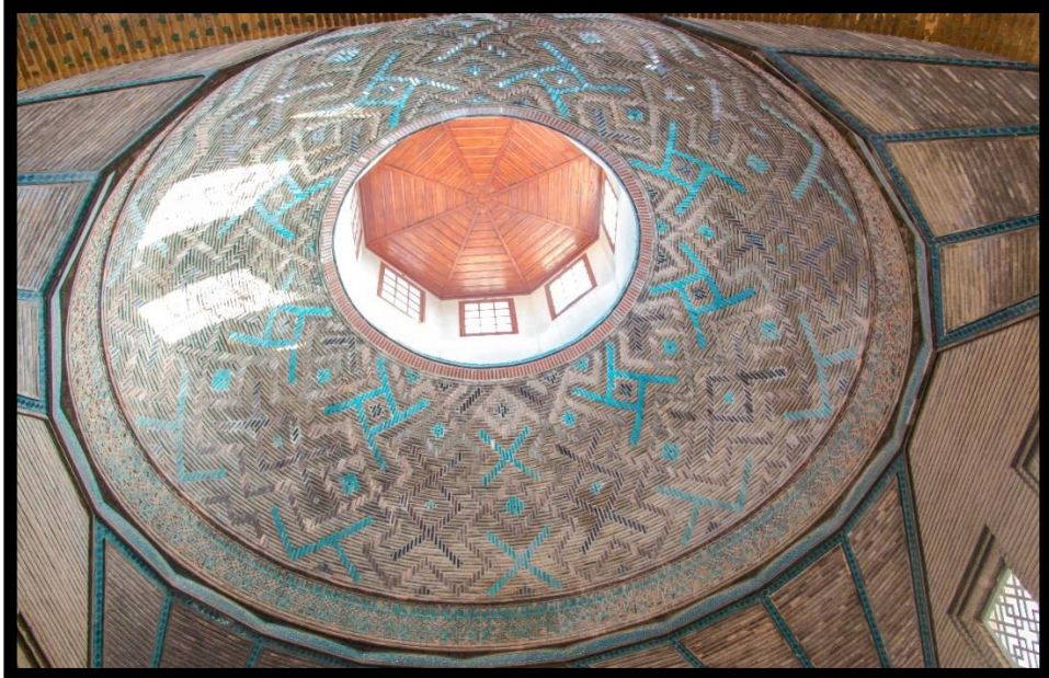
Şekil 5.7. Medresenin Kubbe örtüsü ve aydınlık feneri
