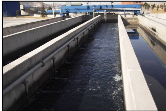
Resim 2.20. Kum ve yağ tutucu bölüm [58]
