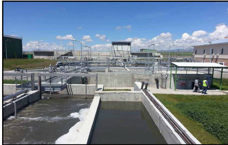
Resim 2.13. Erzurum Atıksu Arıtma Tesisi [50]
