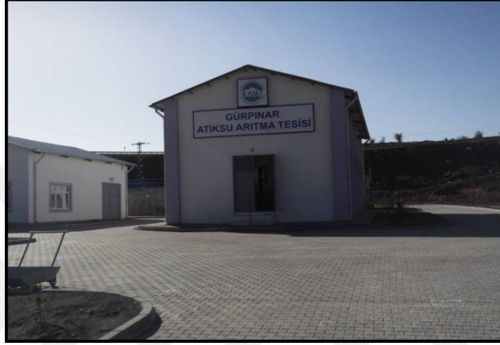
Resim 2.31. Gürpınar Atıksu Arıtma Tesisi görünümü [58]
