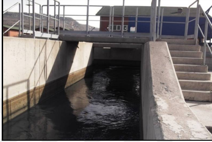
Resim 2.21. Giriş debi ölçüm kanalı [58].
