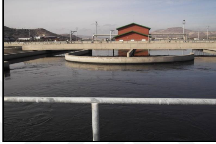
Resim 2.23. Biyolojik fosfor giderim tankı [58]
