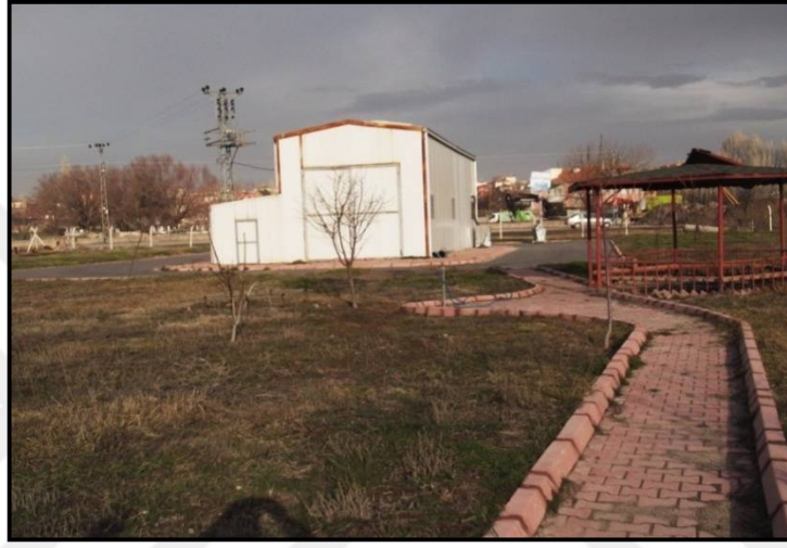
Resim 2.39. Buğdaylı Atıksu Arıtma Tesisi [58]
