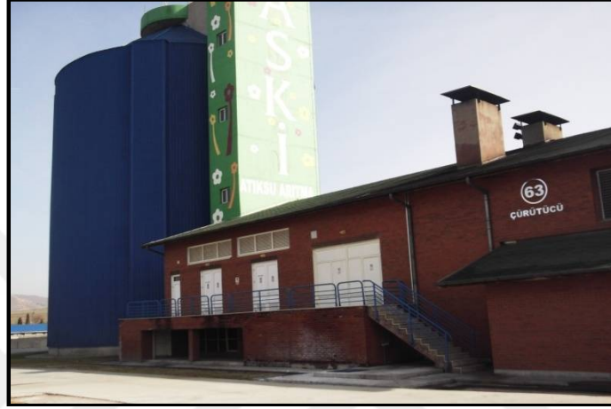
Resim 2.29. Çamur çürütme binası [58]
