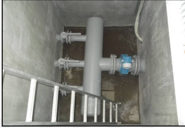
Resim 2.33. Debi ölçüm cihazı [58]
