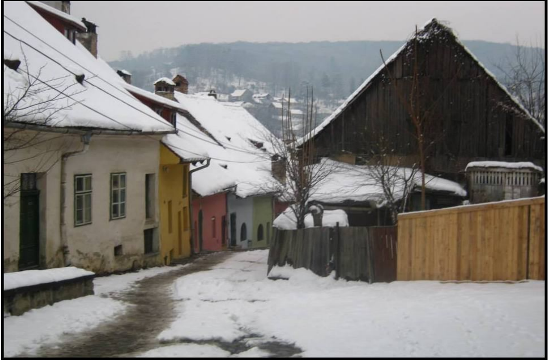
Şekil 7.2. Geleneksel Rumen Mimarisine Göre İnşa Edilen Konut Tipleri
