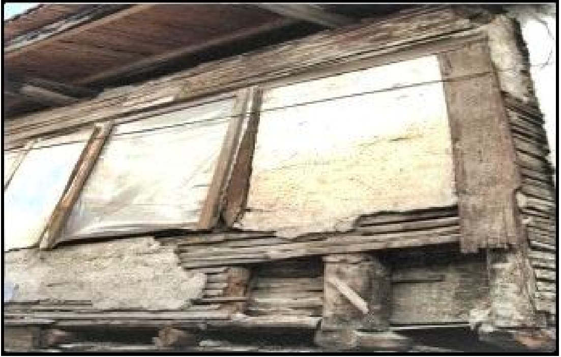
Őekil 2.2. Geleneksel konutlarda baėdadi tekniėi [Ergn ve avdar, 2010]
