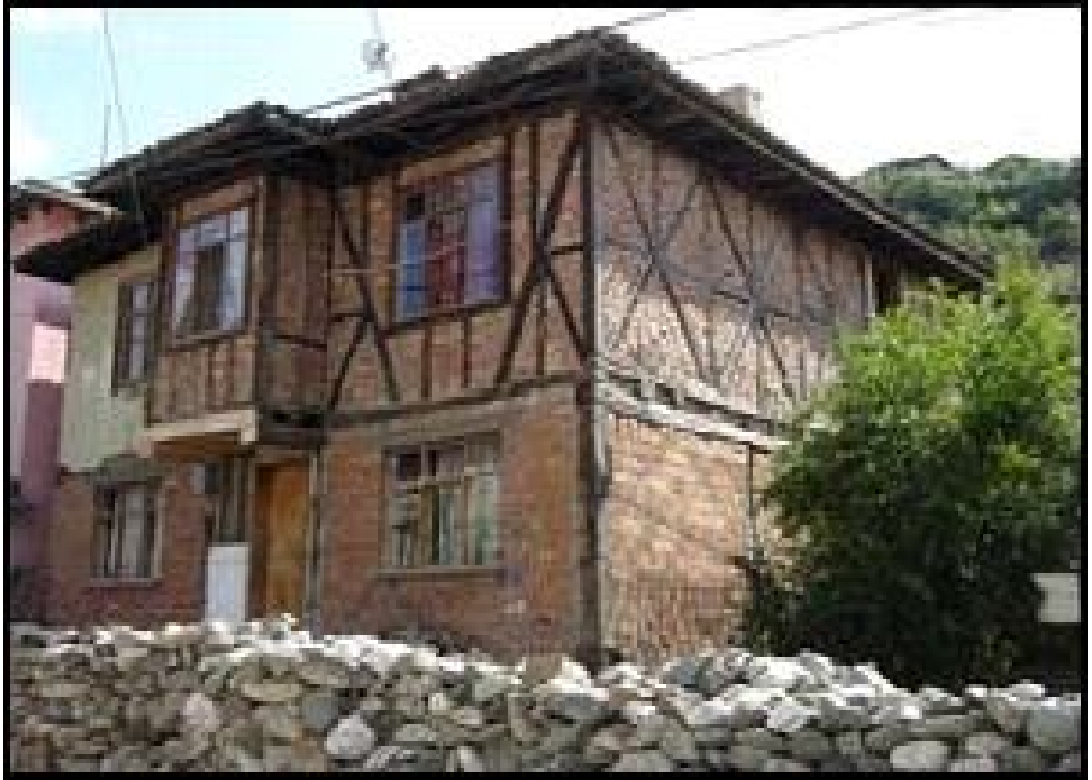
Şekil 2.1. Geleneksel konutlarda malzeme kullanımı [Ufuk ve Eyüpgiller, 2004]
