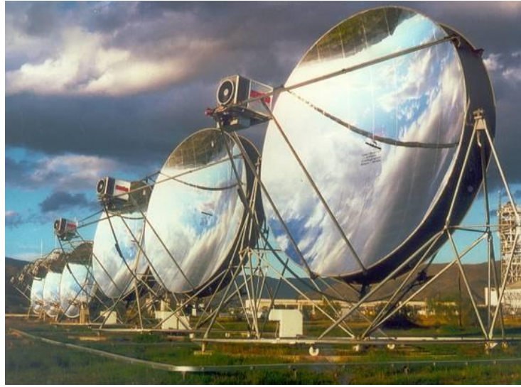
Şekil 3.17. Parabolik çanak kolektörler (YEGM, 2012)
