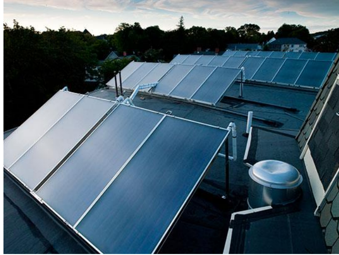
Şekil 3.7. Düzlemsel güneş kolektörü (Sea Solar Store, 2007)
