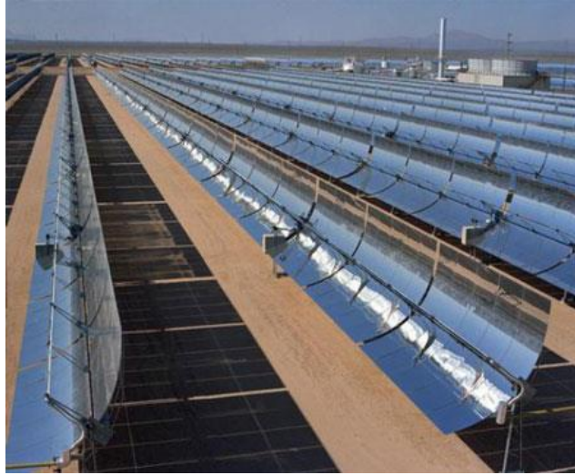
Şekil 3.15. Silindirik parabolik kollektör (Unienerji, 2007)
