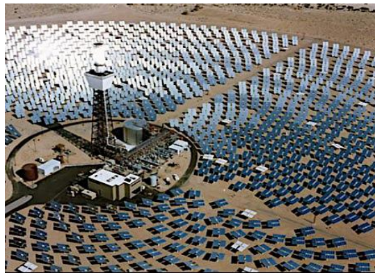
Şekil 3.19. Solar One güneş güç kulesi (Global Greenhouse Warming, 2013)
