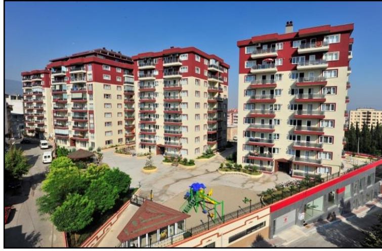
Şekil 3.5 Sinandede Kentsel Dönüşüm Alanından Görünüş (Yıldırım Belediyesi Arşivi, 2010)
