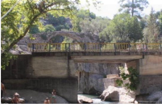
Şekil 4.28 Mevcut Beton köprü
