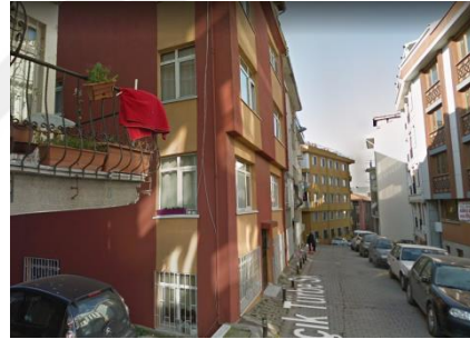
Apartmanın günümüzdeki hali, 2019 (Web İletisi 62)
