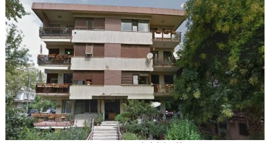
Apartmanın günümüzdeki hali, 2019 (Web İletisi-35)
