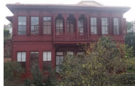
Konağın 2017'deki hali, kuzey yan cephe (Web İletisi 67)
