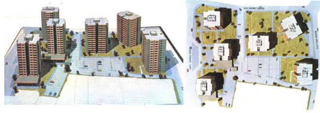
Resim 2.17. Feneryolu Toplu Konut Tesisleri/Kadıköy (Web İletisi 11)
