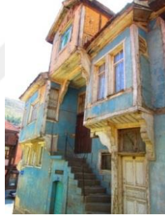
Şekil 5.16. Girişi vurgulayan dikdörtgen çıkma
