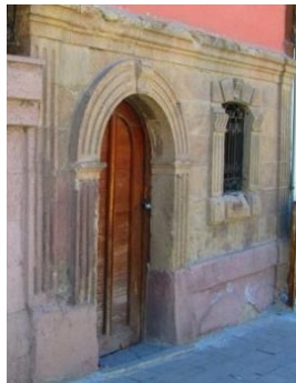
Şekil 5.12. Bodrum kat tali kapısı
