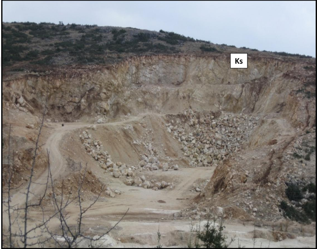
Şekil 4.26. Kum çakıl ocağının kuzeydoğusunda Söbüdağ kireçtaşı (Ks)'nda açılmış kireçtaşı ocağından bir görünüm
