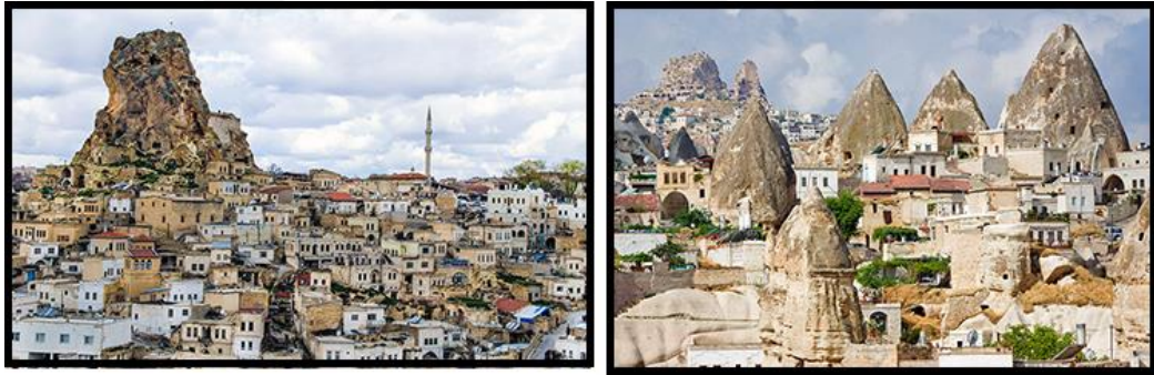
Şekil 2.5. Bölge ölçeğindeki yapıtlar ( Url 18)
