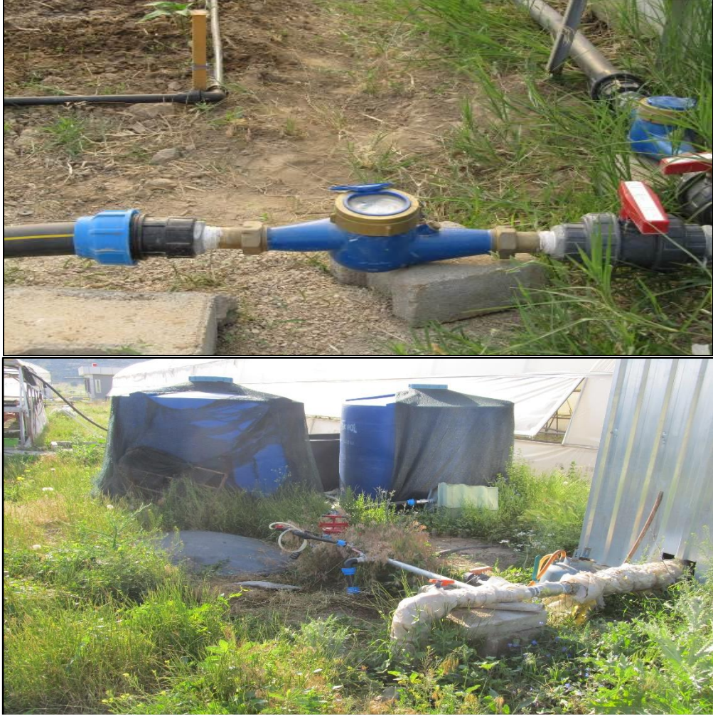
Şekil 3.5. Sulama sistemi, filtre ve sulama sisteminde kullanılan sayaç
