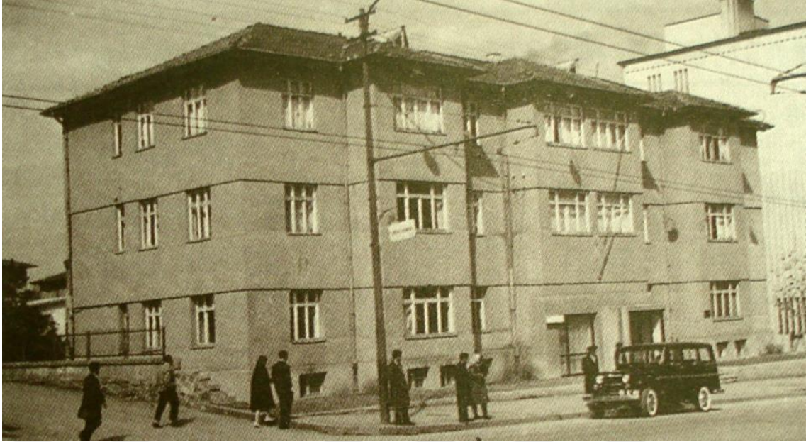
Şekil 4. 24 ODTÜ'nün ilk binası (Payaslıoğlu, 1996, 188)
