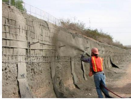
Şekil 2.1. Püskürtme beton uygulaması (Yerlikaya, 2006)
