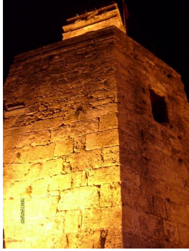
Şekil 4.13. Saat kulesi'nin aydınlatılması
