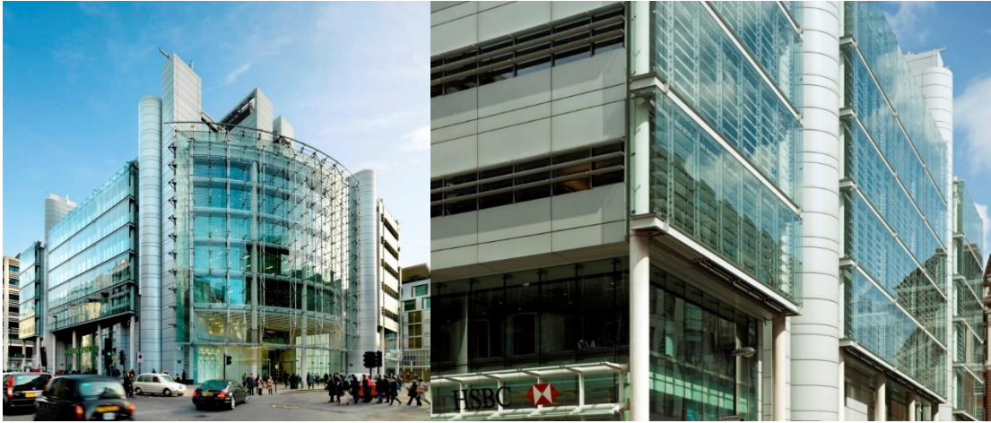
Şekil 2.13. Helicon Finsbury Binası (Web İletisi 11)
