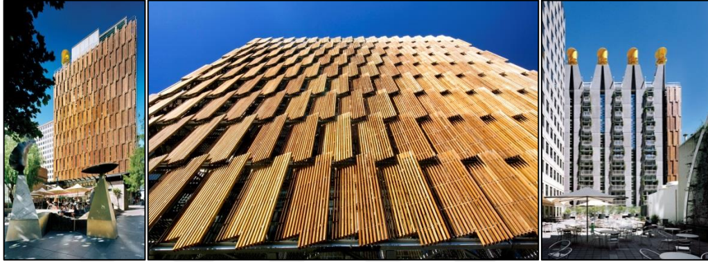
Şekil 4.16. Farklı açılardan CH2 binası (Web İletisi 35)
