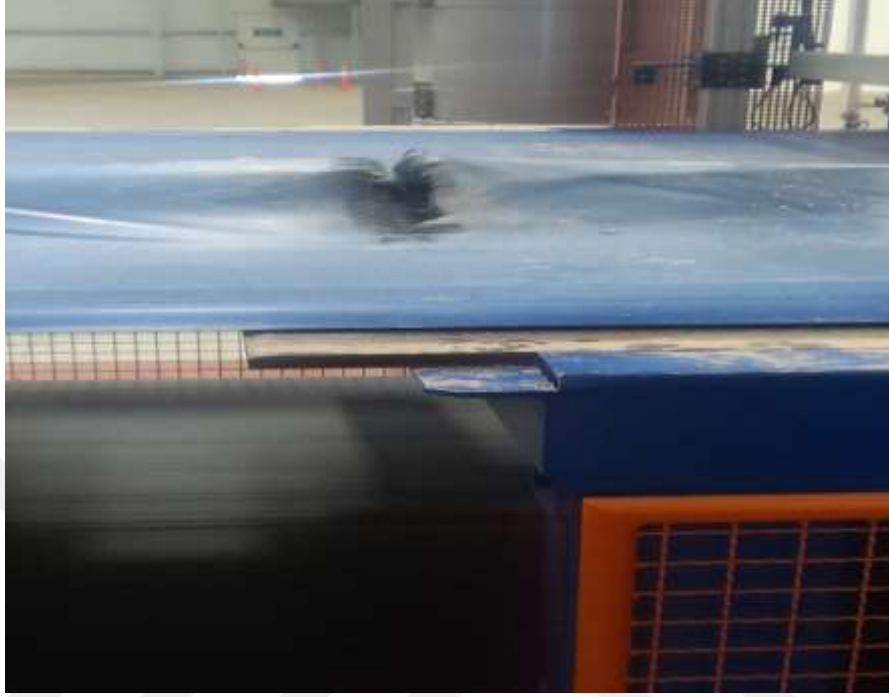
Şekil 1.12. Serme bandının yırtılması ile gerçekleşen arıza
