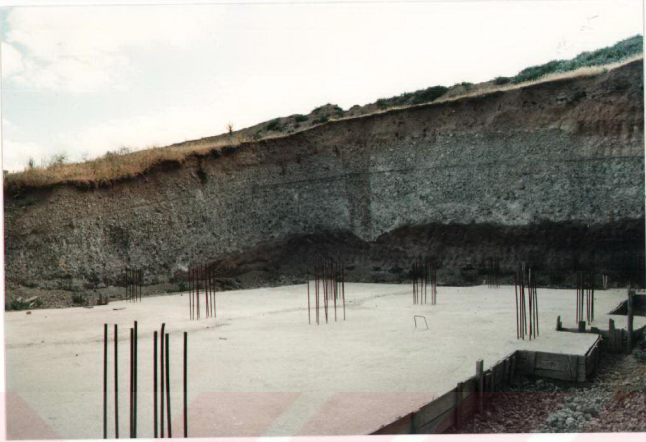
Fotograf 5. BIMS Zeminde Yapılmış Temel İnşaatı (F.Altıntabak)
