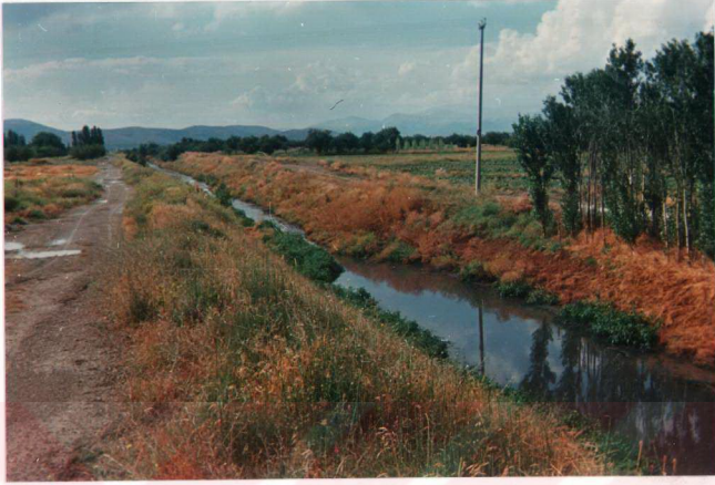
Fotograf 1. DSI Drenaj Kanalı (F.Altıntabak)
