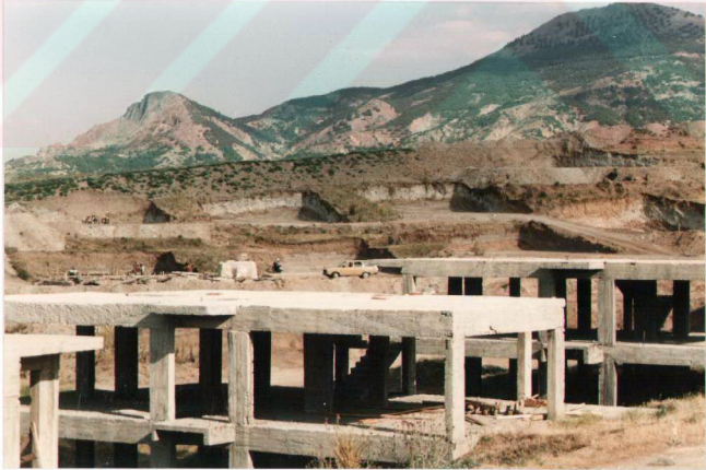
Fotograf 6. BIMS Zeminde Açılmış Toplu Konut Temelleri (F.Altıntabak)
