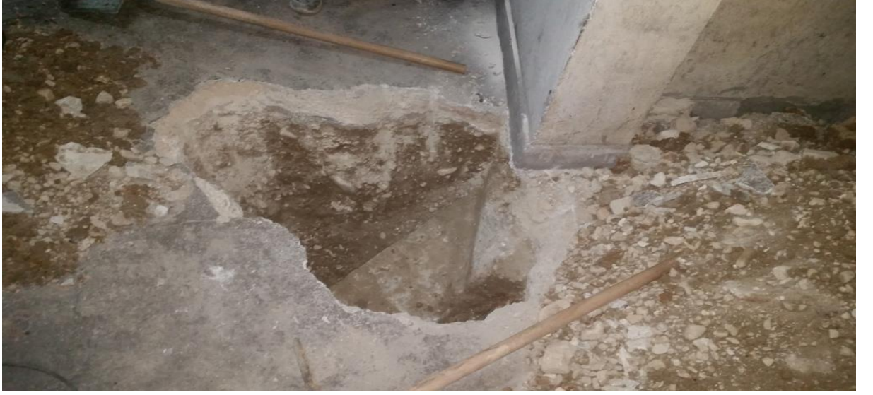
Şekil 5.16. Bina giriş sıyırma ve çukur gözlemi
