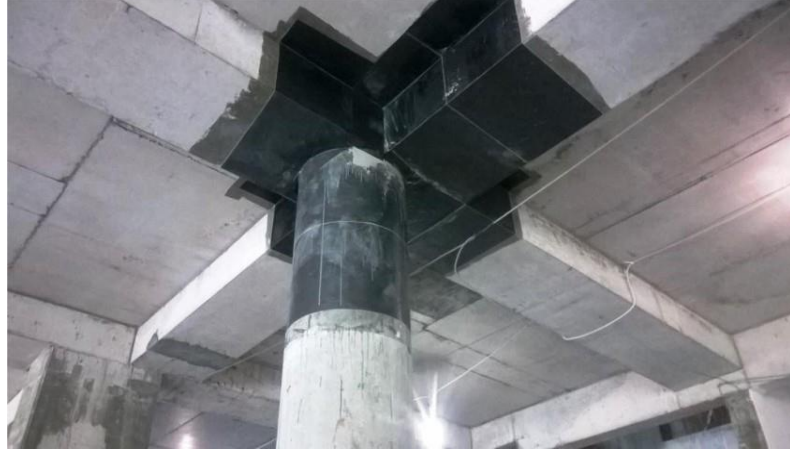
Şekil 3.3. Karbon Fiber Kumaş İle Sargılama Yöntemi
