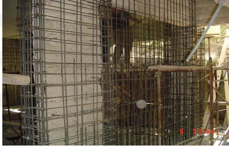
Şekil 3.4. Kolon Mantolama
