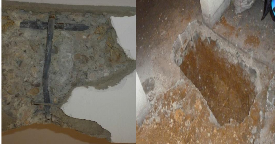
Şekil 5.2. Bina kiriş sıyırma ve çukur gözlemi
