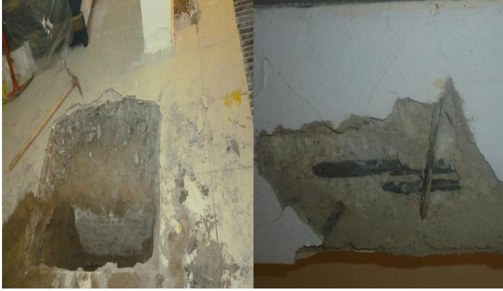
Şekil 5.10. Bina giriş sıyırma ve çukur gözlemi
