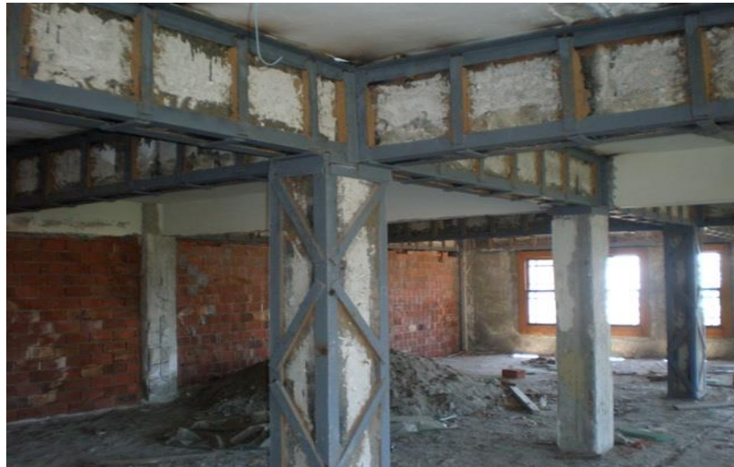
Şekil 3.2. Çelik Mantolama Yöntemi
