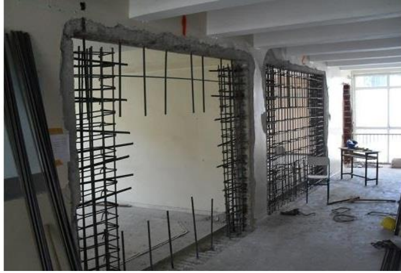
Şekil 3.1. Perde Eklenmesi
