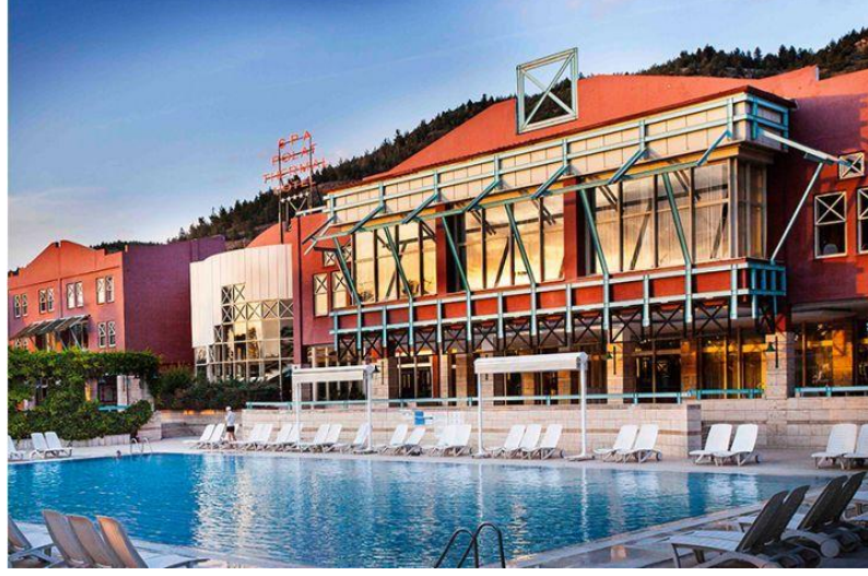
Şekil 3.59. Polat Thermal Otel, cephe düzeni (Url-40)
