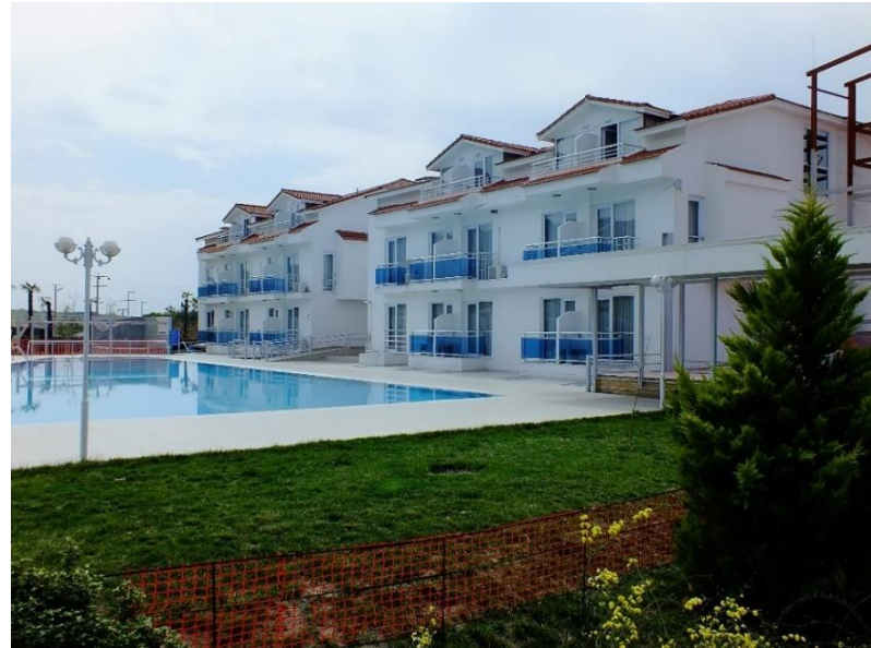
Şekil 3.97. Ninova Thermal, Spa & Hotel, genel tesis görüntüsü (Aköz, 2017)
