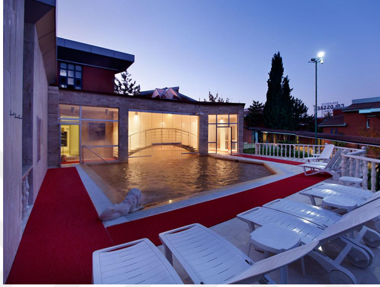
Şekil 3.22. Colossae Spa & Thermal Hotel, termal su havuzu (Url-37)
