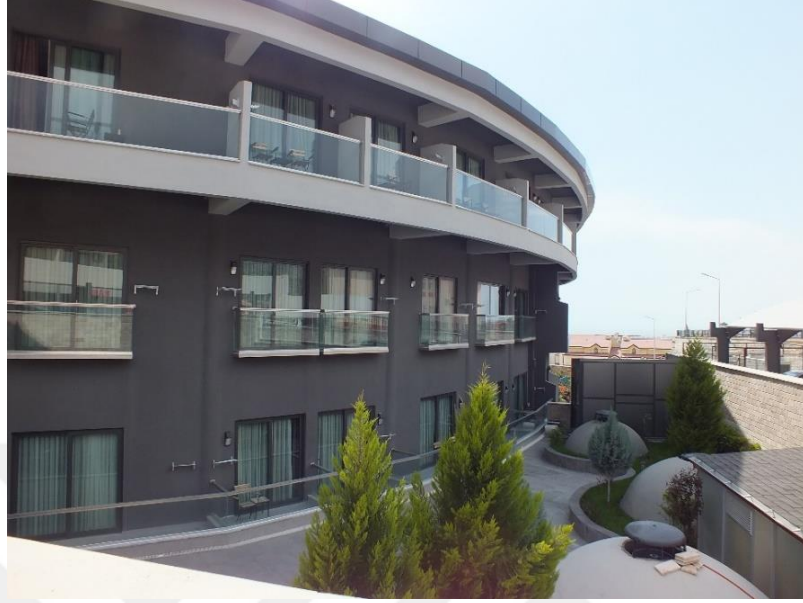
Şekil 3.51. Doğa Thermal Hotel Health & Spa, cephe düzeni (Aköz, 2017)
