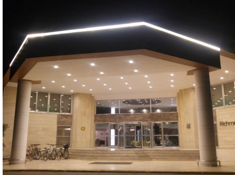
Şekil 3.75. Richmond Pamukkale Thermal Resort, tesis girişi (Aköz, 2017)
