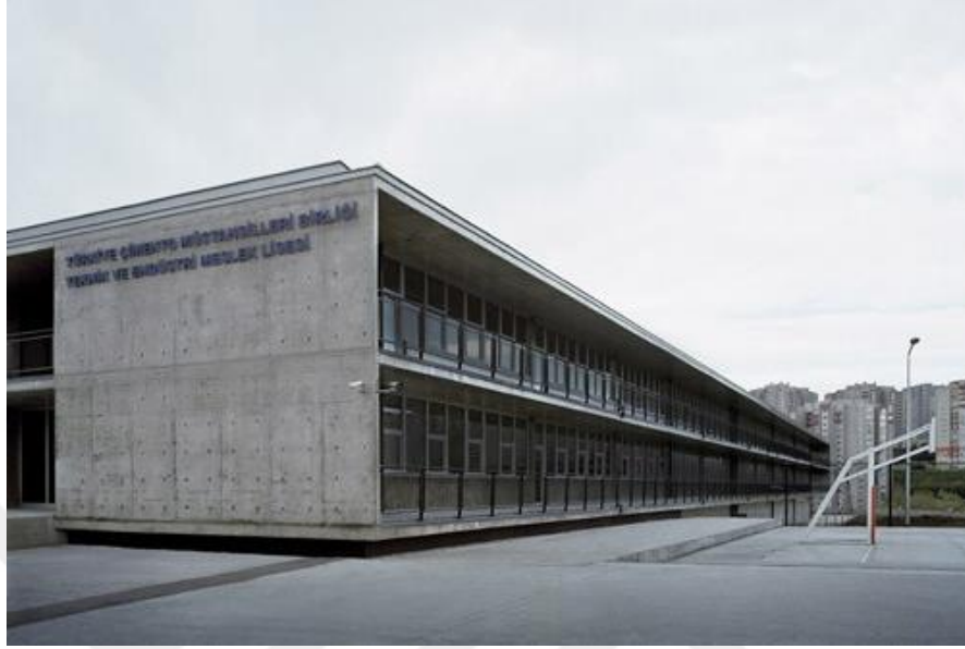
řekil 2.27. Yapı cephesinde brüt beton malzeme kullanımı (Url-22)
