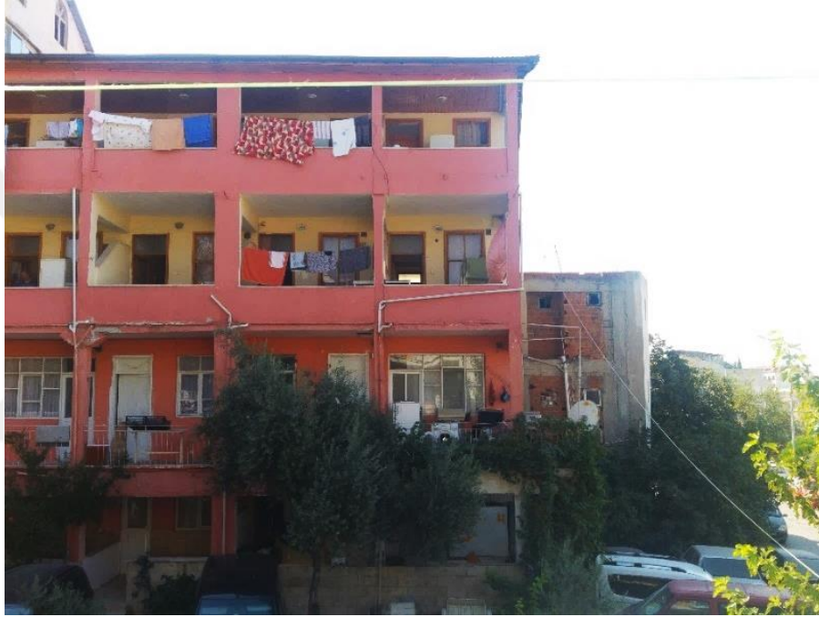
Şekil 3.16. Karahayıt'ta bir pansiyonun cephesine ait görünüşler (Aköz, 2017)
