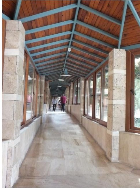
Şekil 3.54. Polat Thermal Hotel, bloklar arası kapalı geçitler (Aköz, 2017)
