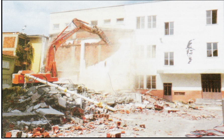
Resim 4. Deprem Sonrası Atatürk İlköğretim Okulu Yıkım Çalışmaları.
