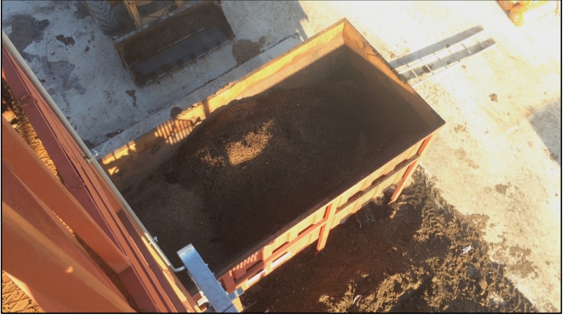
Şekil 3.8: Besleme sistemi ana bunker.
