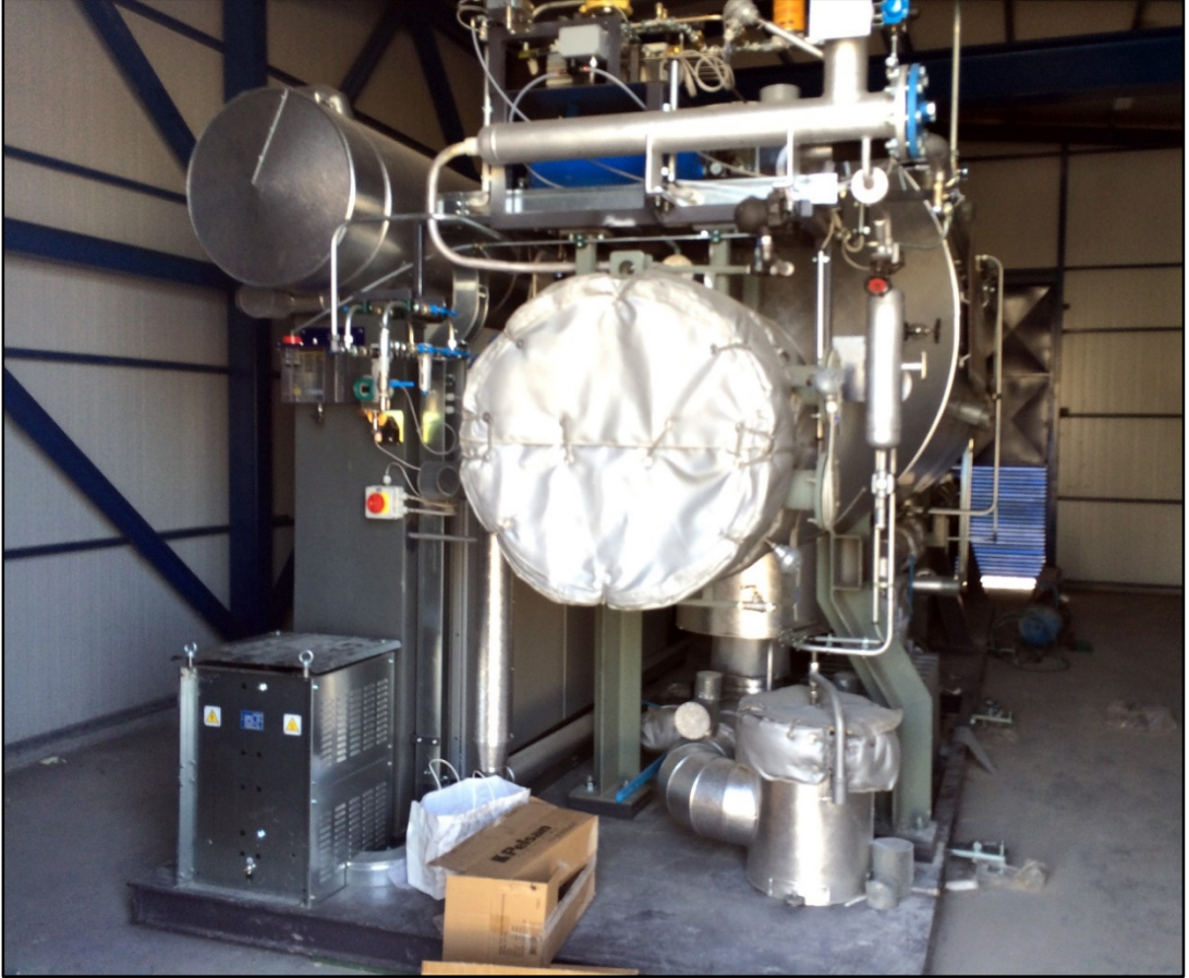
Şekil 3.14: 300 kWe kapasiteli ORC Türbini, Bursa Marmarabirlik tesisleri.
