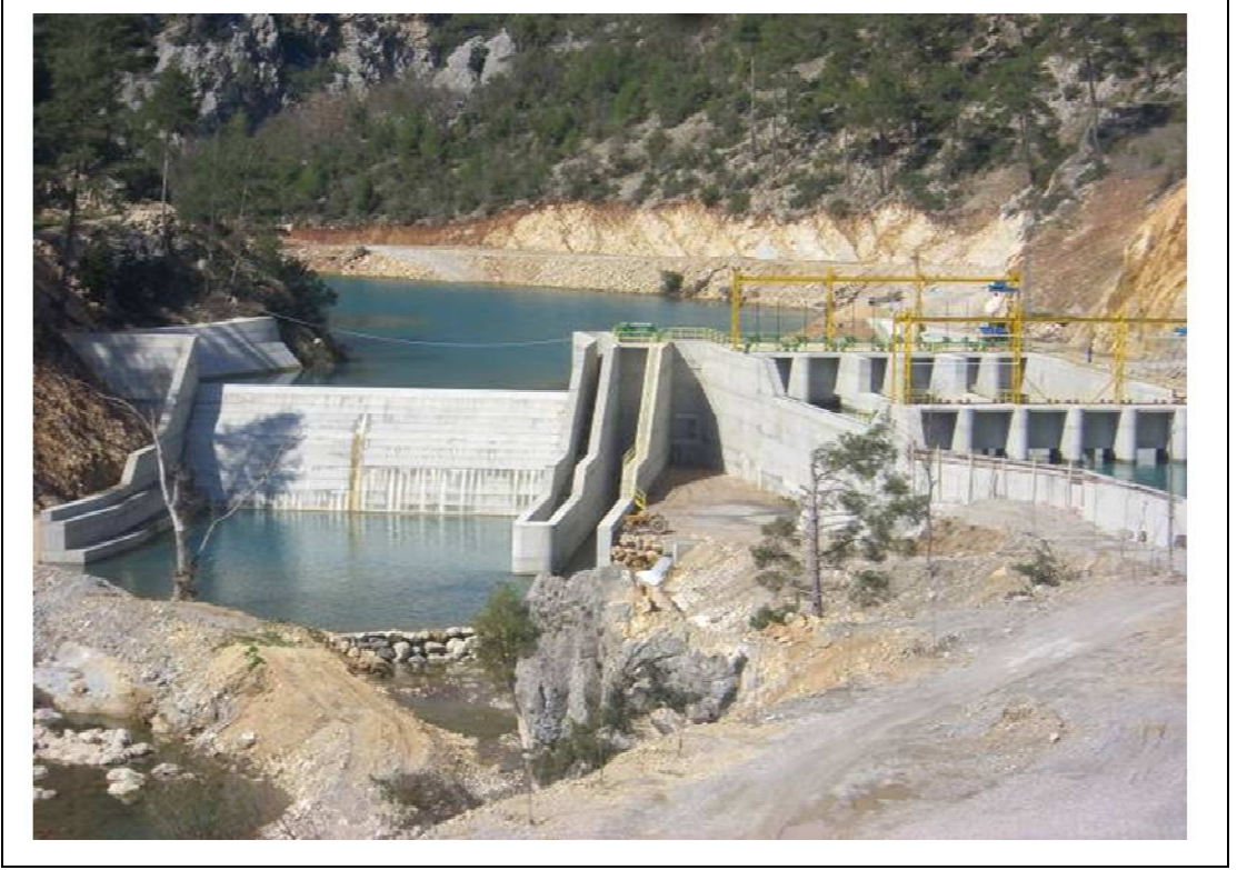
Şekil B1.1: Regülatör-sualma yapısı-çökeltim havuzu.
