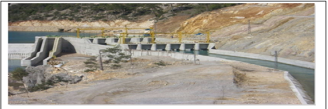
Şekil 3.5: Su alma ağız yapısı görünüm örneği.
