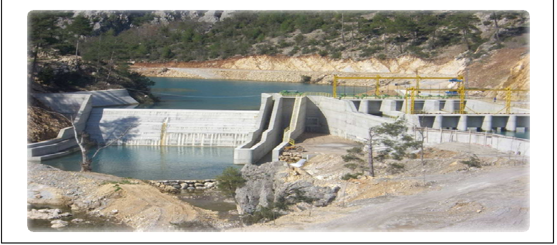
Şekil 3.4: Su alma yapısı görünüm örneği.
