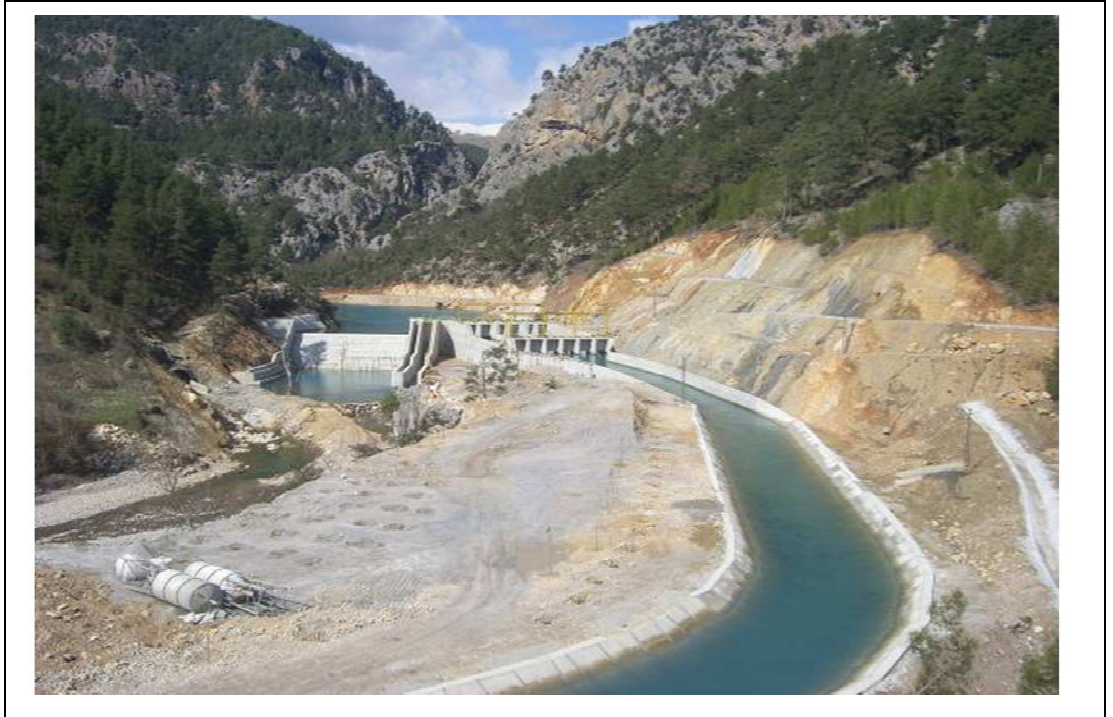
Şekil B1.2: Regülatör-sualma yapısı-çökeltim havuzu.
