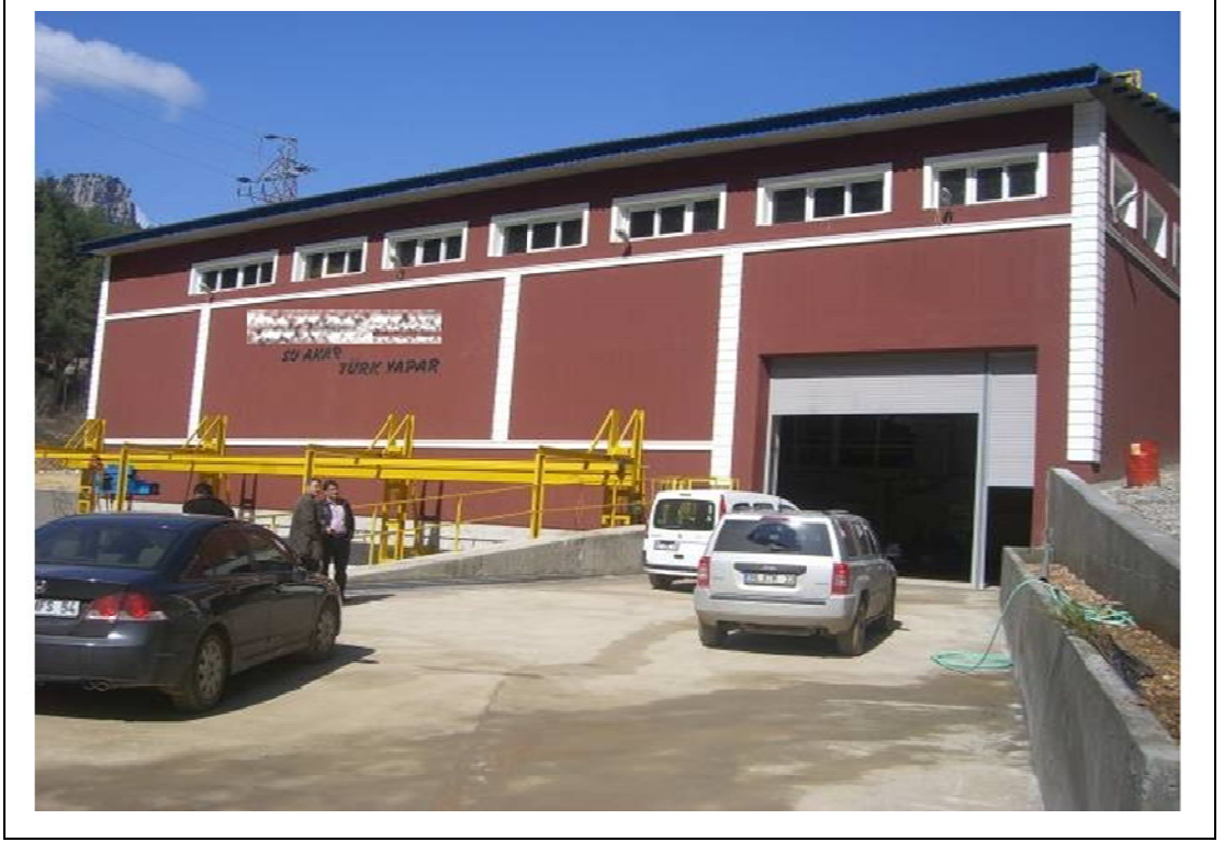
Şekil B1.5: Santral binası.
