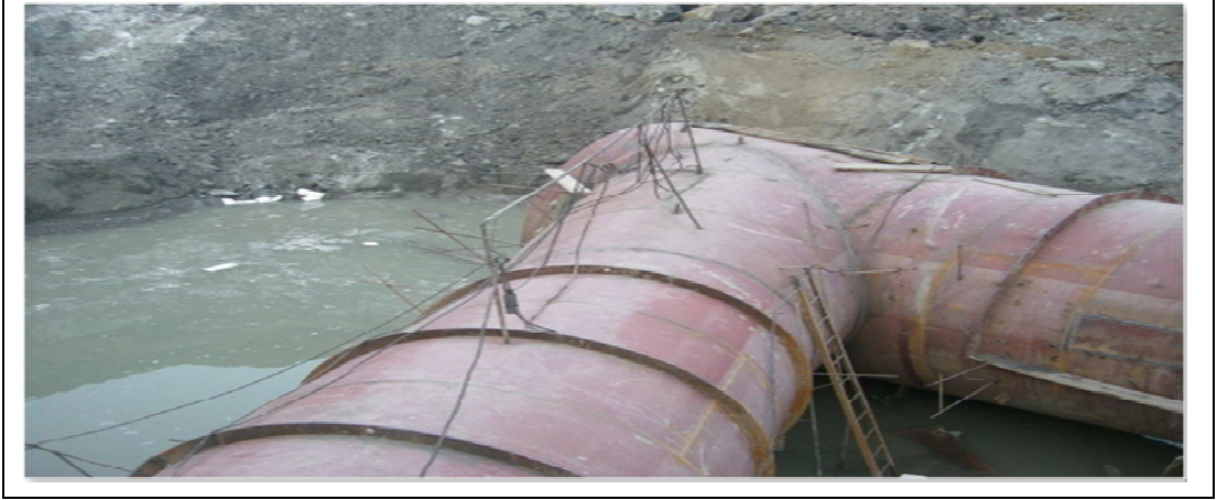
Şekil 3.6:Cebri(basınçlı) borular görünüm örneği.
