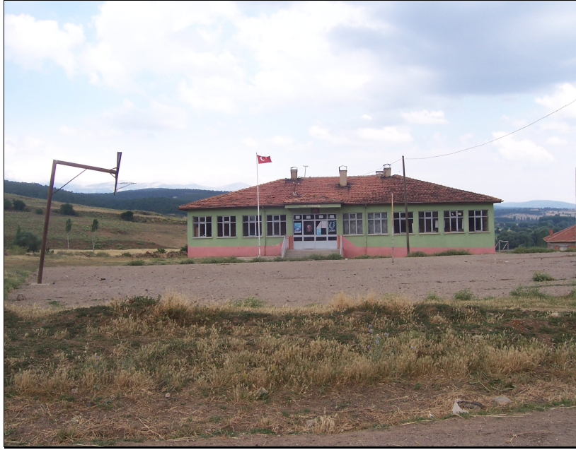
Fotoğraf 13. Ayrancı Köyü İlköğretim Okulu'nun Genel Görünümü.
