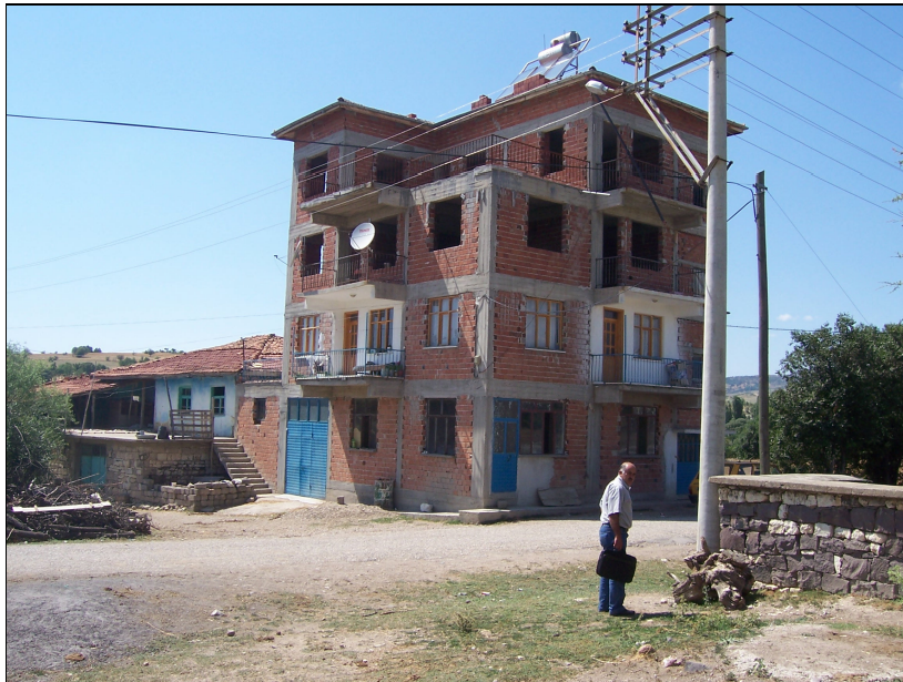
Fotoğraf 7. Mesudiye Köyünde Modern Yapı Malzemesiyle İnşa Edilmiş Bir Meskenin Genel Görünümü.
