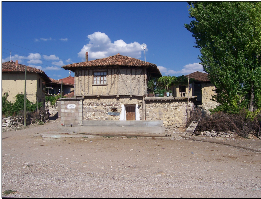
Fotoğraf 4. Mesudiye Köyü Sakinlerinden Güldane Demir’e Ait Ahşap Karkas Dolgu Malzemesi İle Yapılmış Bir Meskeninin Görünümü.
