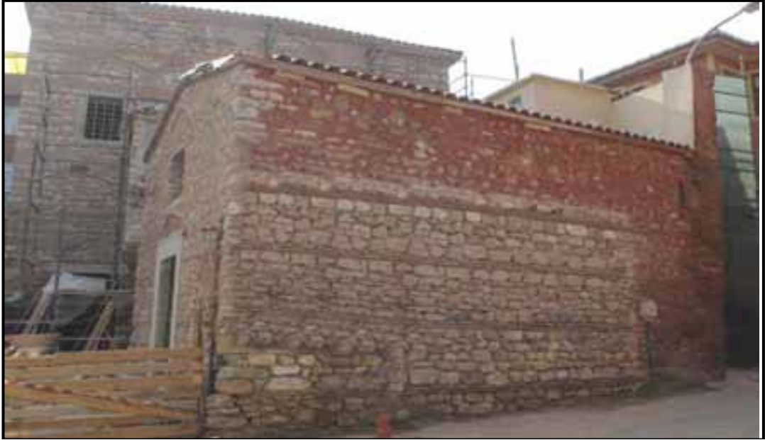
Resim 3.43: Fatih Mahkeme Binası'nın restorasyondan önceki hali.
