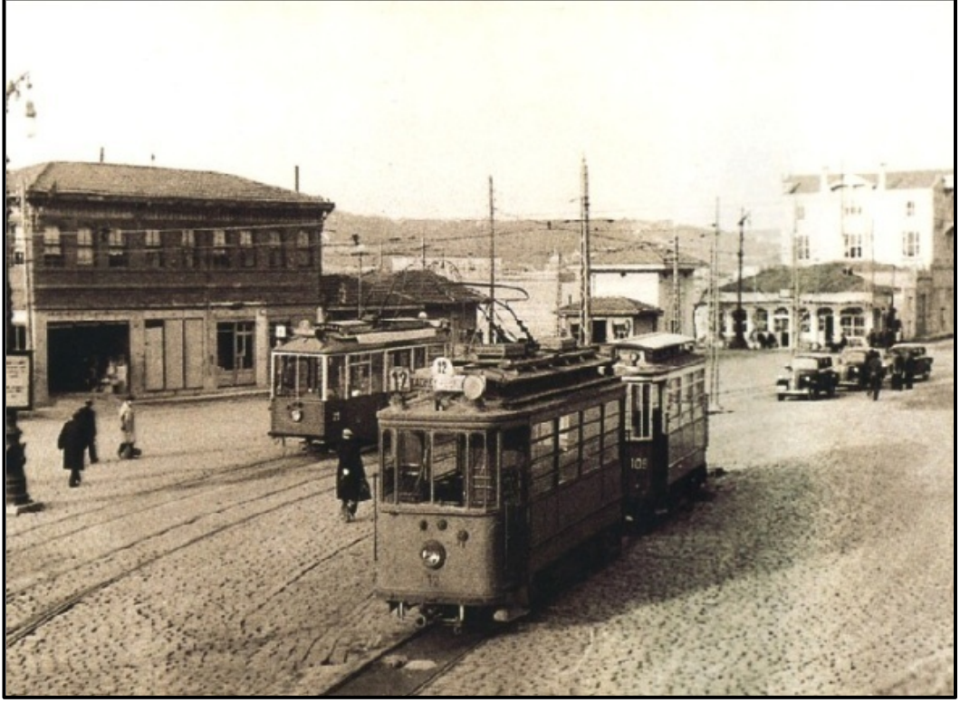
Resim 3.21: Kadıköy-Üsküdar-Kısıklı Tramvay Hattı.
