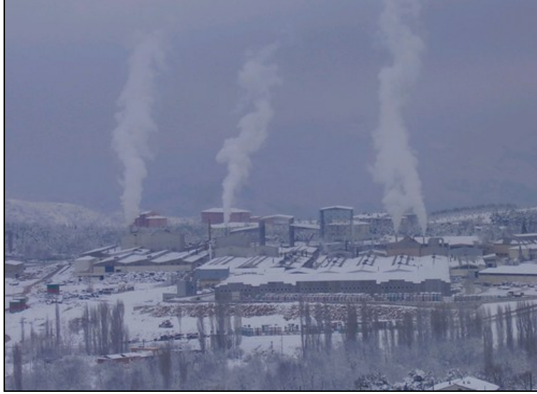
Fotoğraf 19. İlçe Merkezindeki Sanayi Tesislerinin Çevre Kirliliğine Etkisi
