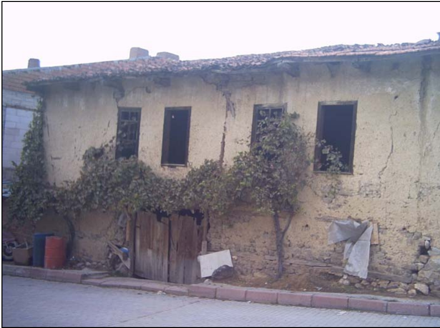
Fotoğraf 17. İlçe Merkezindeki Eski Bir Konut.
