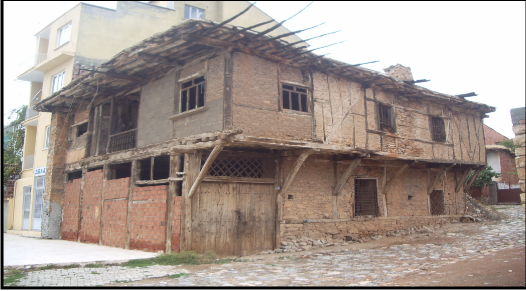
Fotoğraf 19: Karahallı İlçe Merkezinde Ahşap İskeletten Yapılan Toprak Mesken.
