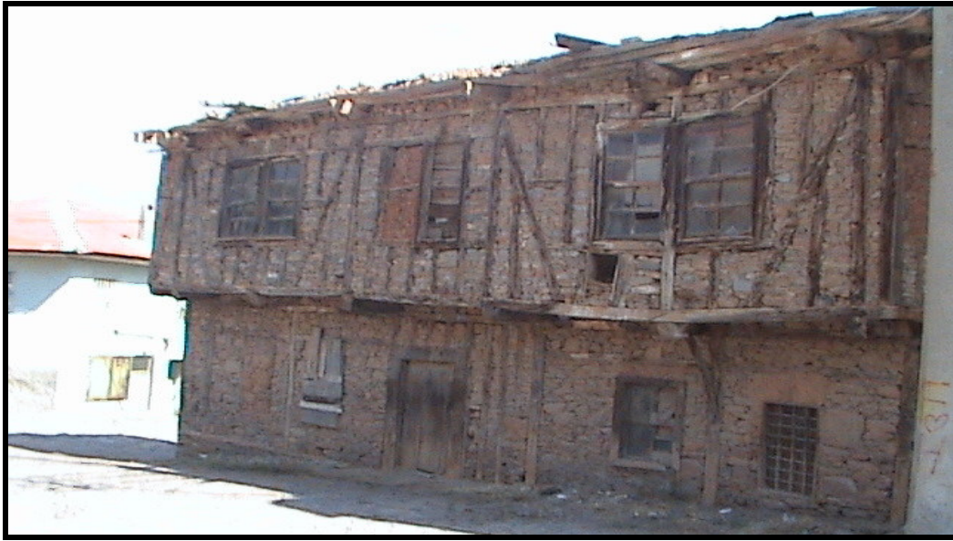
Fotoğraf 18: Karahallı İlçe Merkezinde Dolgu Yöntemi Kullanılarak Yapılan Taş Ev.
