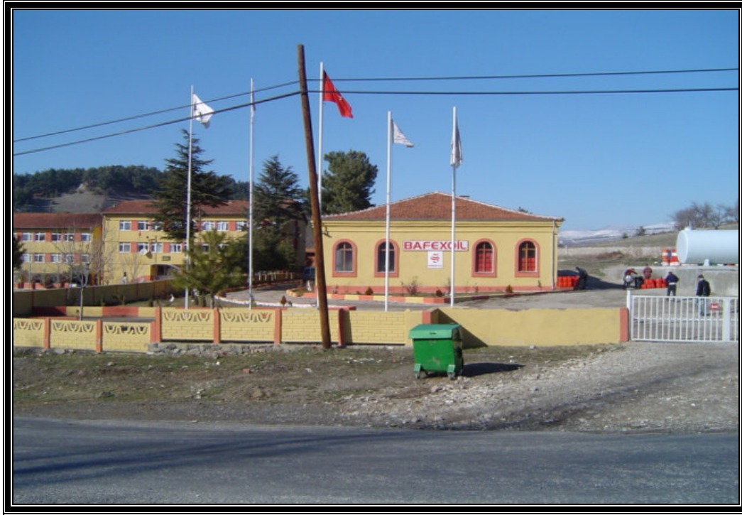
Foto 25. Bafexoil Madeni Yağ Fabrikasından Genel Bir Görünüm.
