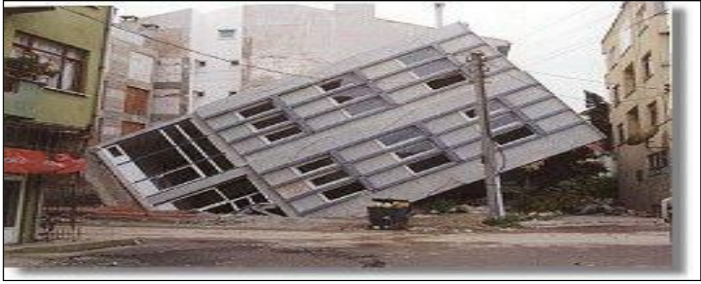
Şekil 2.25: Taşıma gücü kaybı sonucu yan yatan bir bina Gölçük Türkiye -1999.
