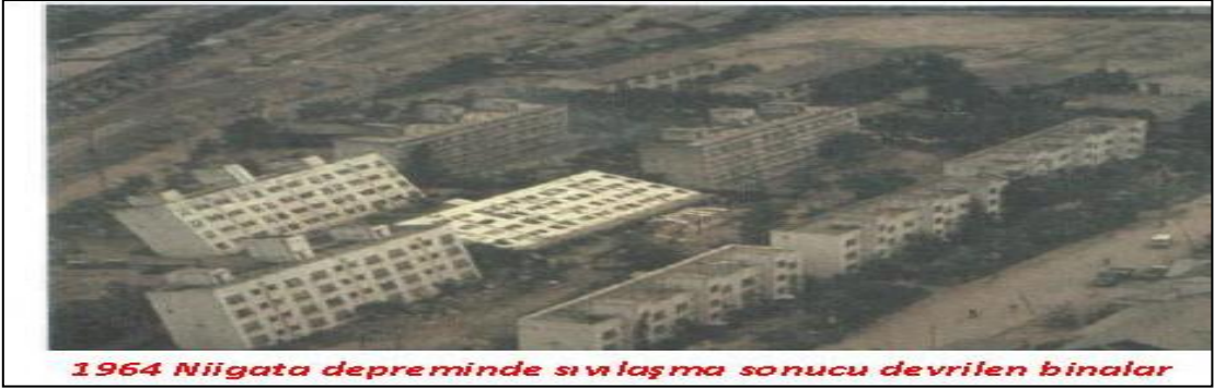
Şekil 2.21: Niigata Japonya -1964 depremi sonucu taşıma gücü kaybına uğramış zemin sonucu devrilen binalar.
