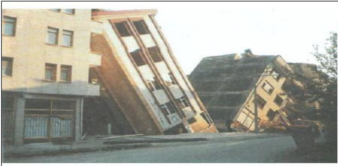
Şekil 2.23: Taşıma gücü kaybı sonucu devrilen binalar Adapazarı Türkiye -1999.
