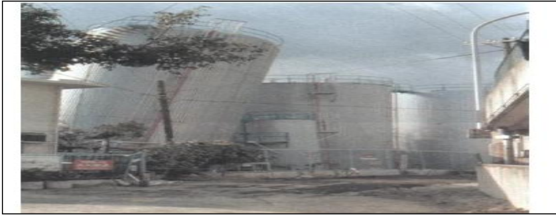
Şekil 2.22: Taşıma gücü kaybı ile devrilen silo yapısı Adapazarı Türkiye – 1999.
