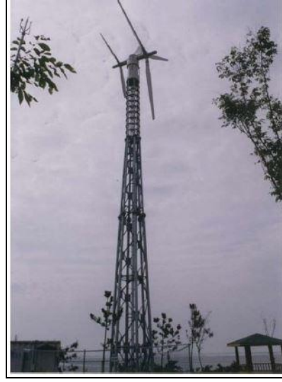
Şekil 1.8: 30 kW gücünde çift rotorlu rüzgâr türbini.
